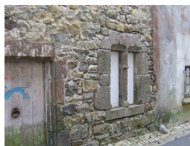
Maison n° 8 (?), détail : baie à meneaux, à 2 accolades Phot. Françoise Péron IVR53_20062908412NUCA
