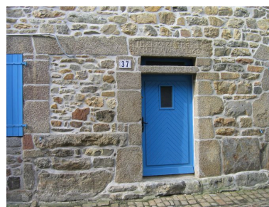
Maison n° 37, détail : porte avec seuil surélevé et linteau gravé Phot. Françoise Péron IVR53_20062908411NUCA
