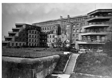
Vue d'ensemble de l'hôpital Augustin-Morvan Phot. Guy Artur, Phot. Norbert Lambart IVR53_19942900423XB
