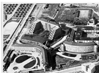
Vue aérienne oblique de l'hôpital Augustin-Morvan Phot. Guy Artur, Phot. Norbert Lambart IVR53_19942900391XB
