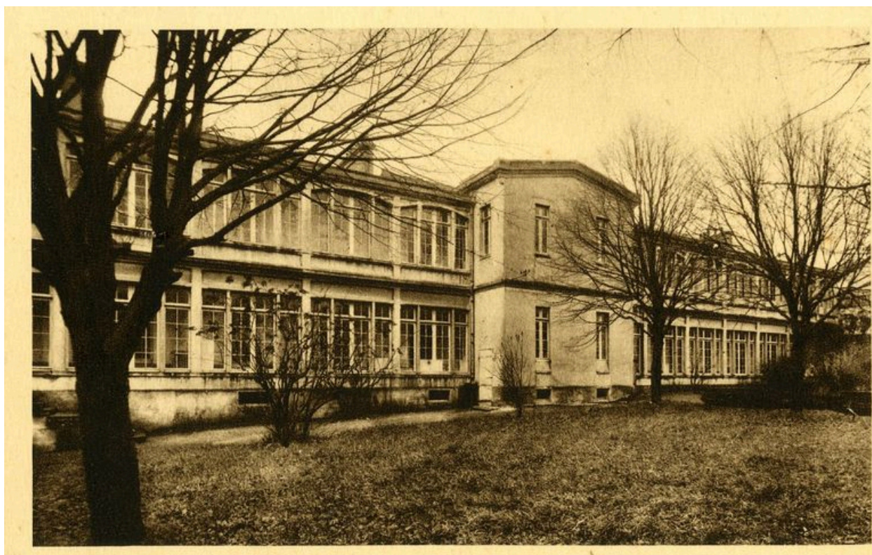
L'hôpital maritime de Brest : les bâtiments. Carte postale
