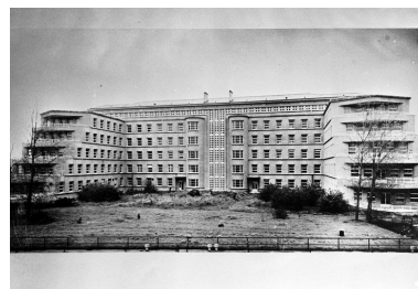
Vue d'ensemble de l'hôpital Augustin-Morvan Phot. Guy Artur, Phot. Norbert Lambart IVR53_20042903444NUCA
