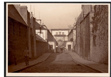
L'hôpital maritime de Brest : entrée Phot. Archives municipales et communautaires. Brest Métropole Océane IVR53_20082909097NUC
