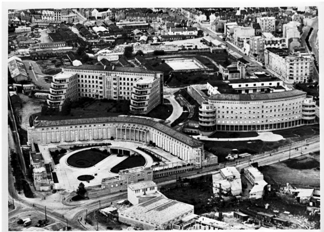
Vue aérienne oblique de l'hôpital Augustin-Morvan
