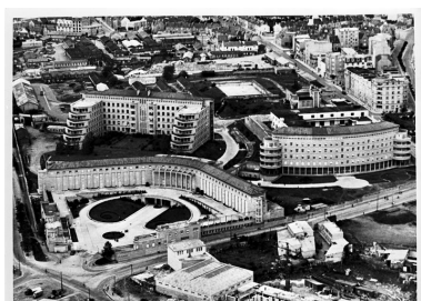
Vue aérienne oblique de l'hôpital Augustin-Morvan Phot. Guy Artur, Phot. Norbert Lambart IVR53_19942900385XB
