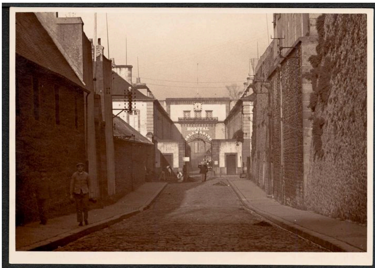
L'hôpital maritime de Brest : entrée
