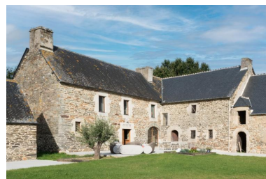
Ensemble de deux logis, l'un édifié au 16e siècle, l'autre en 1760 par Jean-François Le Goff, marchand de toile. Vue générale sud-est. Phot. Charlotte Barraud IVR53_20232201194NUCA
