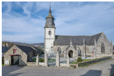
Vue générale sud de l'enclos Phot. Bernard Bègne IVR53_20202200726NUCA
