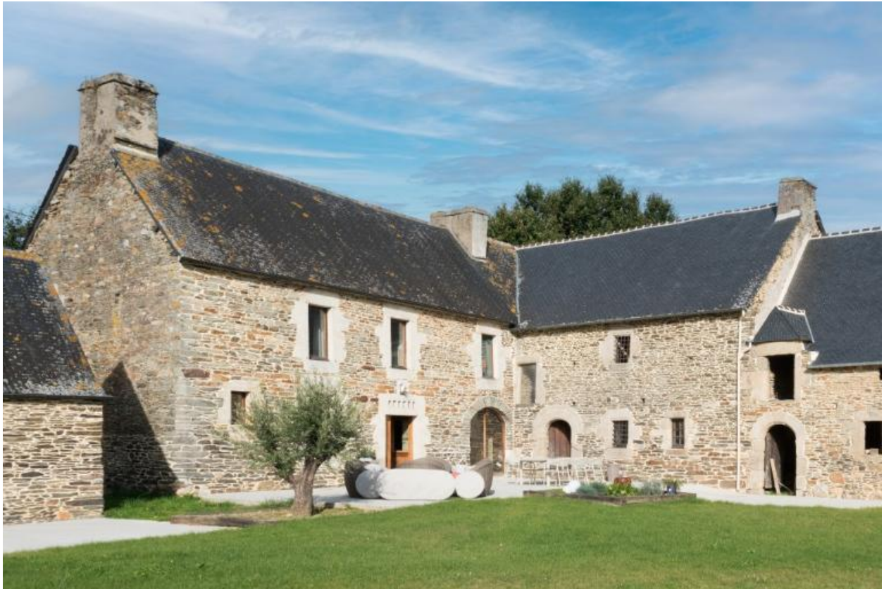
Ensemble de deux logis, l'un édifié au 16e siècle, l'autre en 1760 par Jean-François Le Goff, marchand de toile. Vue générale sud-est.
