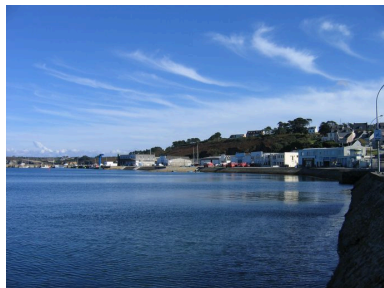
Vue générale de la zone portuaire Téphany Phot. Guillaume Marie IVR53_20062908331NUCA
