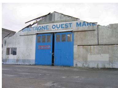
Bâtiment d'Ouest Marée en cours de démolition (décembre 2005) Phot. Françoise Péron IVR53_20062908486NUCA
