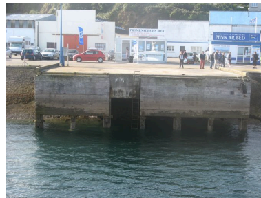
Appontement du quai Téphany Phot. Guillaume Marie IVR53_20082908288NUCA
