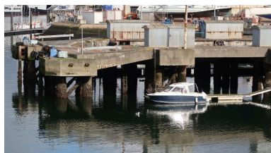
Ascenseur à bateaux Phot. Erwana L'Haridon IVR53_20242911516NUCA
