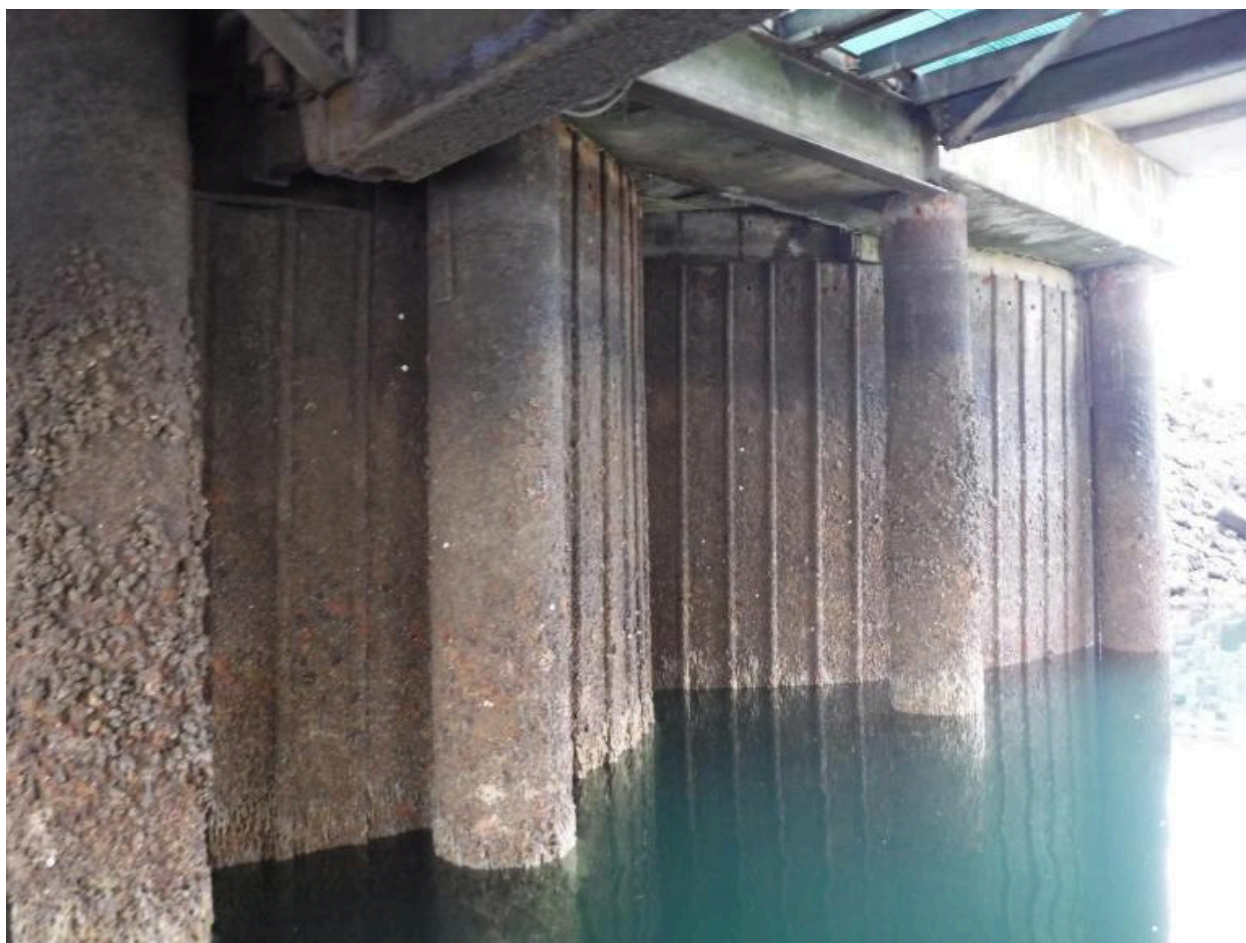
Structure de l'ascenseur à bateaux : gabions
