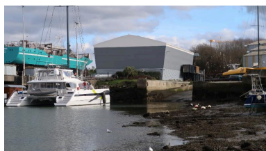
Ascenseur à bateaux Phot. Erwana L'Haridon IVR53_20242911519NUCA
