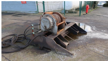
Ascenseur à bateaux : treuil Phot. Erwana L'Haridon IVR53_20242911526NUCA
