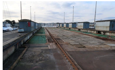
Ascenseur à bateaux Phot. Erwana L'Haridon IVR53_20242911527NUCA
