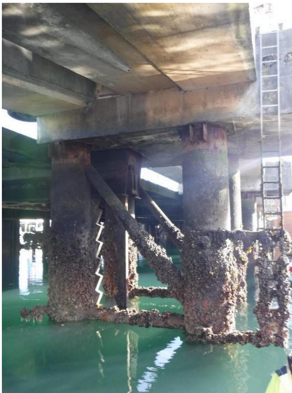
Système de levage de la plateforme de l'ascenseur par crémaillère
