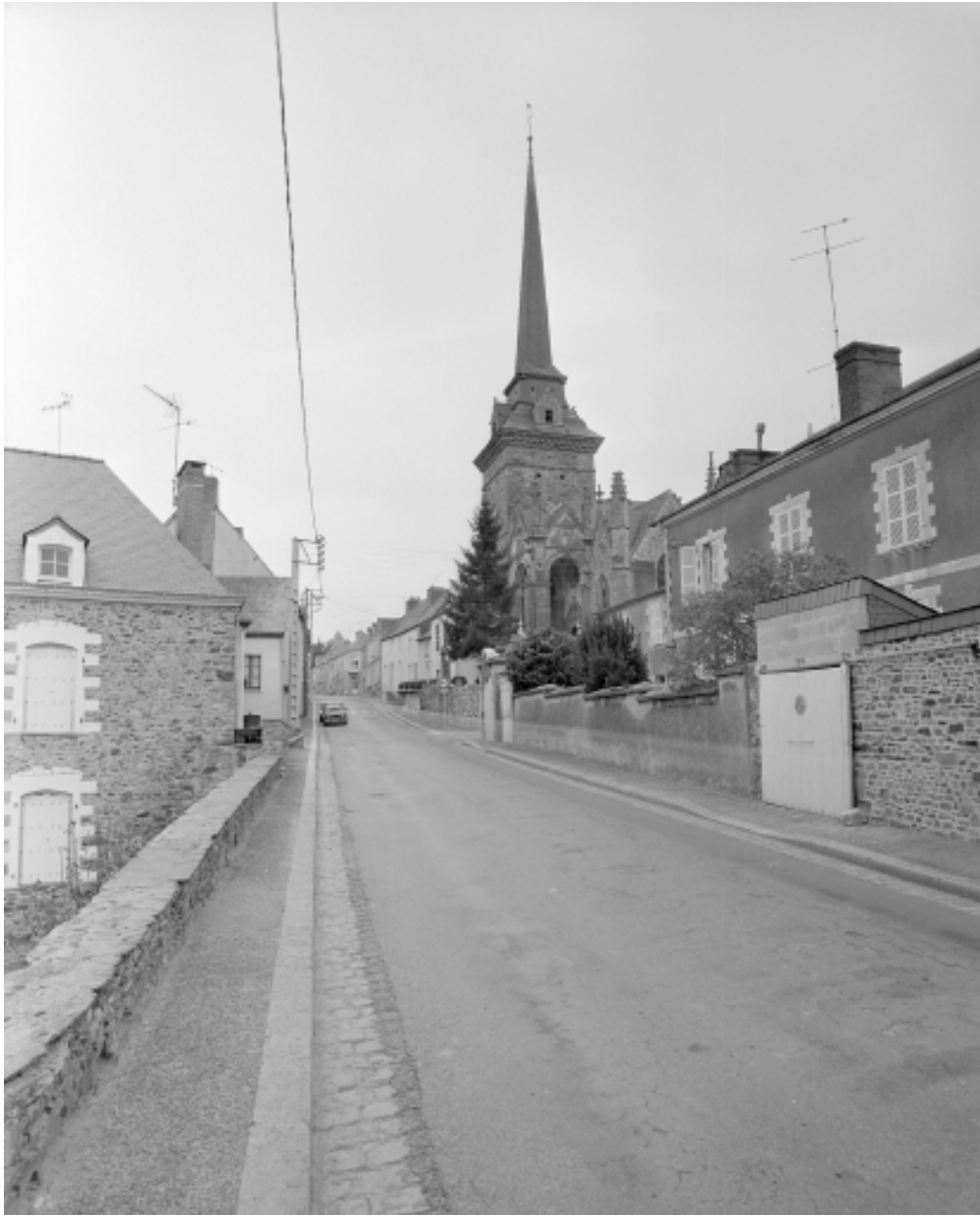
Elévation sud ouest, clocher : vue générale
