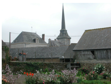
Flèche vue du nord ouest
