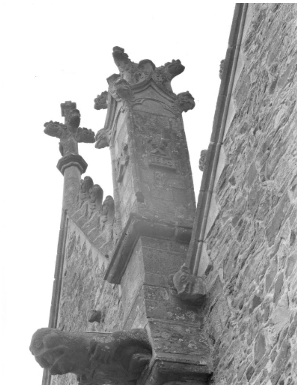
Détail ; pinacle daté 1660 : vue générale
