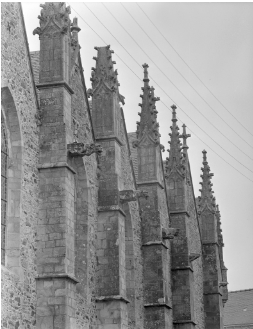
Elévation sud, pinacle en enfilade : vue générale
