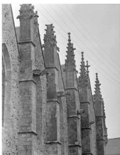
Elévation sud, pinacle en enfilade : vue générale
