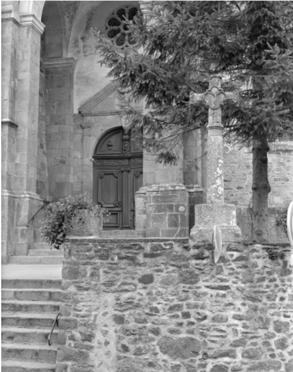
Elévation ouest, porte d'entrée : vue générale
