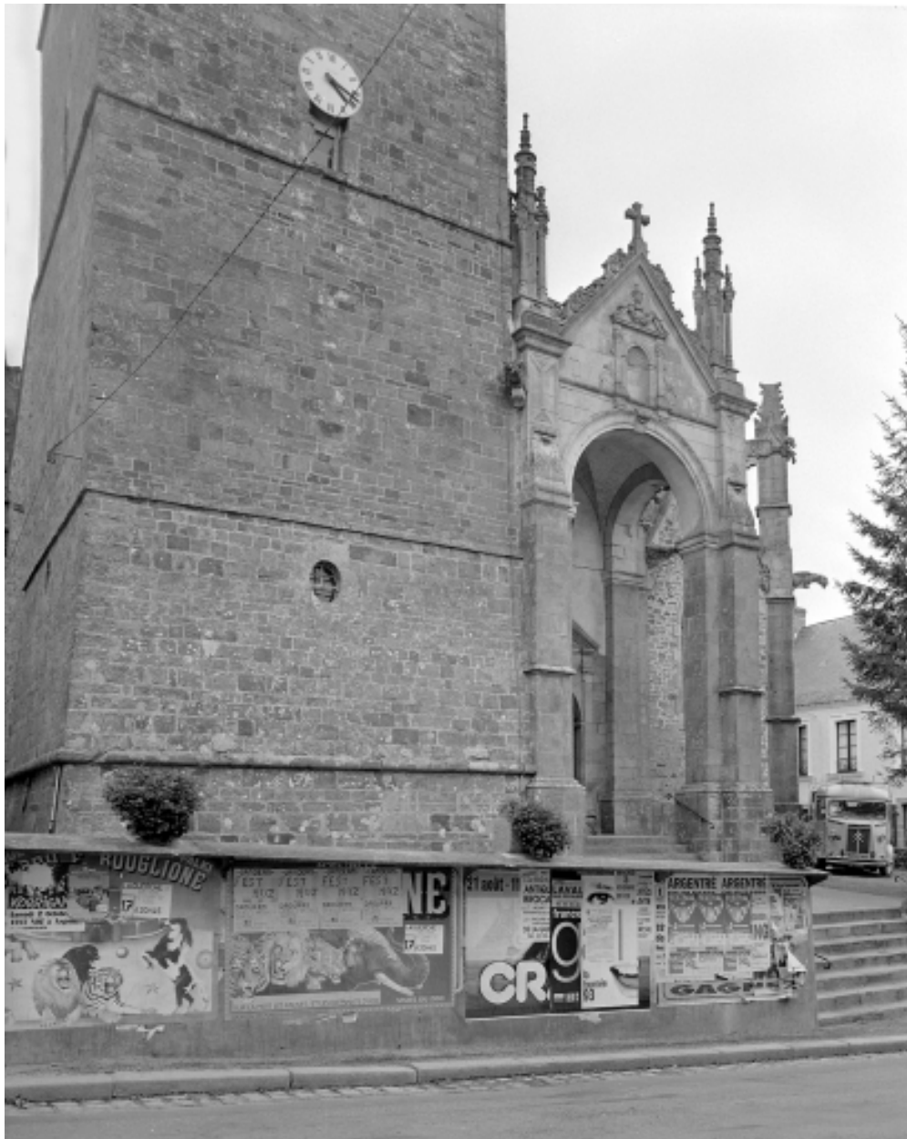
Elévation ouest, partie basse : vue générale
