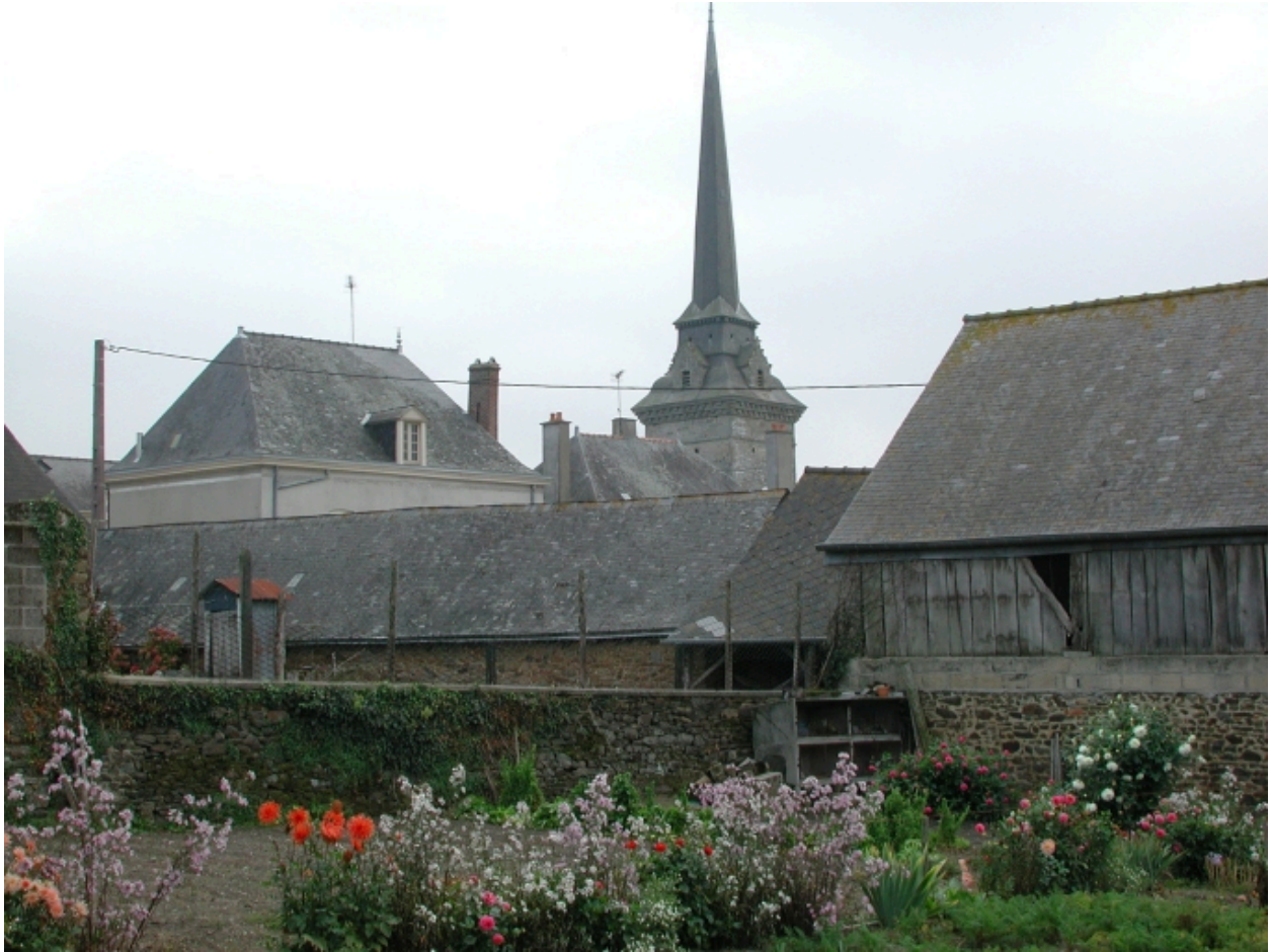
Flèche vue du nord ouest
