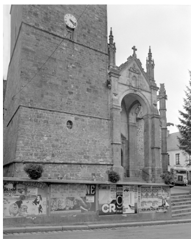
Elévation ouest, partie basse : vue générale
