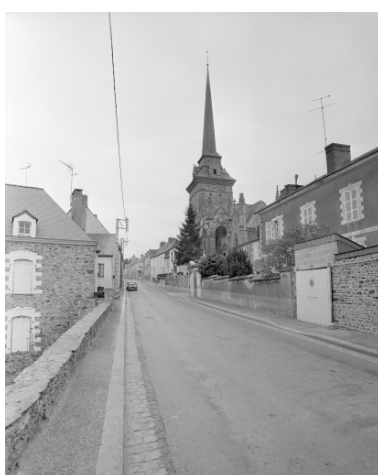
Elévation sud ouest, clocher : vue générale
