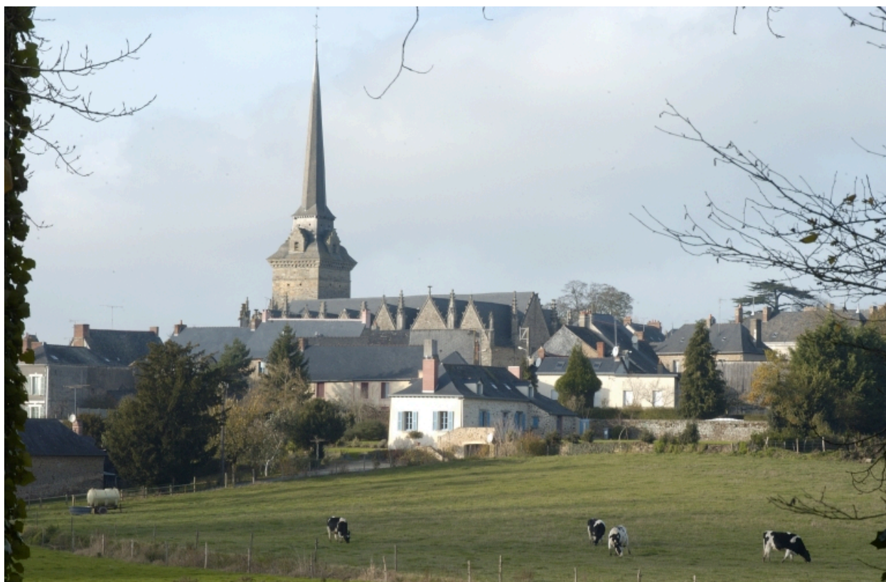
Vue de situation sud est
