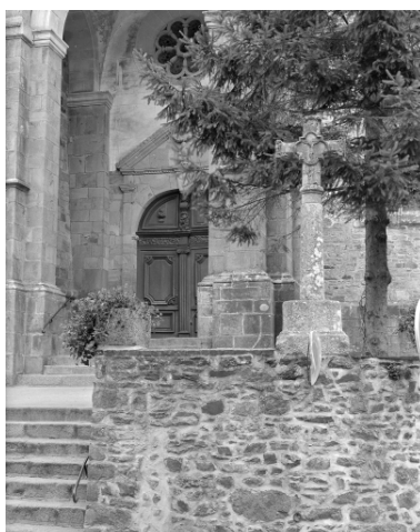
Elévation ouest, porte d'entrée : vue générale
