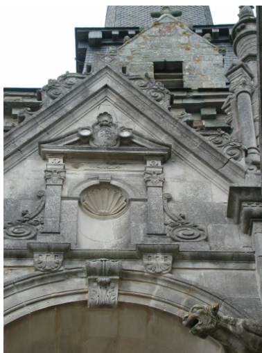
Détail ; porche sud Phot. Claude Quillivic IVR53_20023518095NUCA
