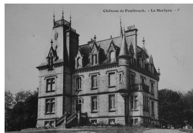
Vue latérale Phot. Elise Lauranceau IVR53_20052904379NUCB
