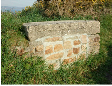
Vue générale (état en 2002) Phot. Guillaume Lécuillier IVR53_20022901914NUCA
