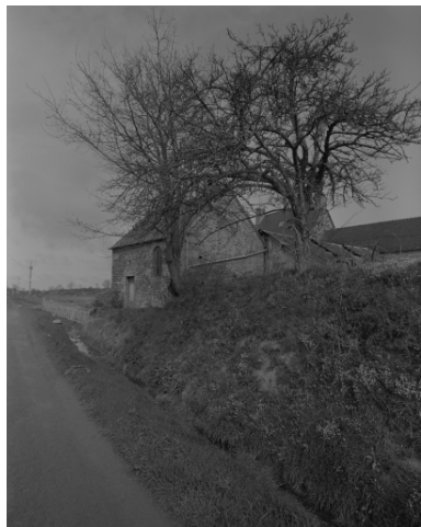
Elévation Est : vue de situation
