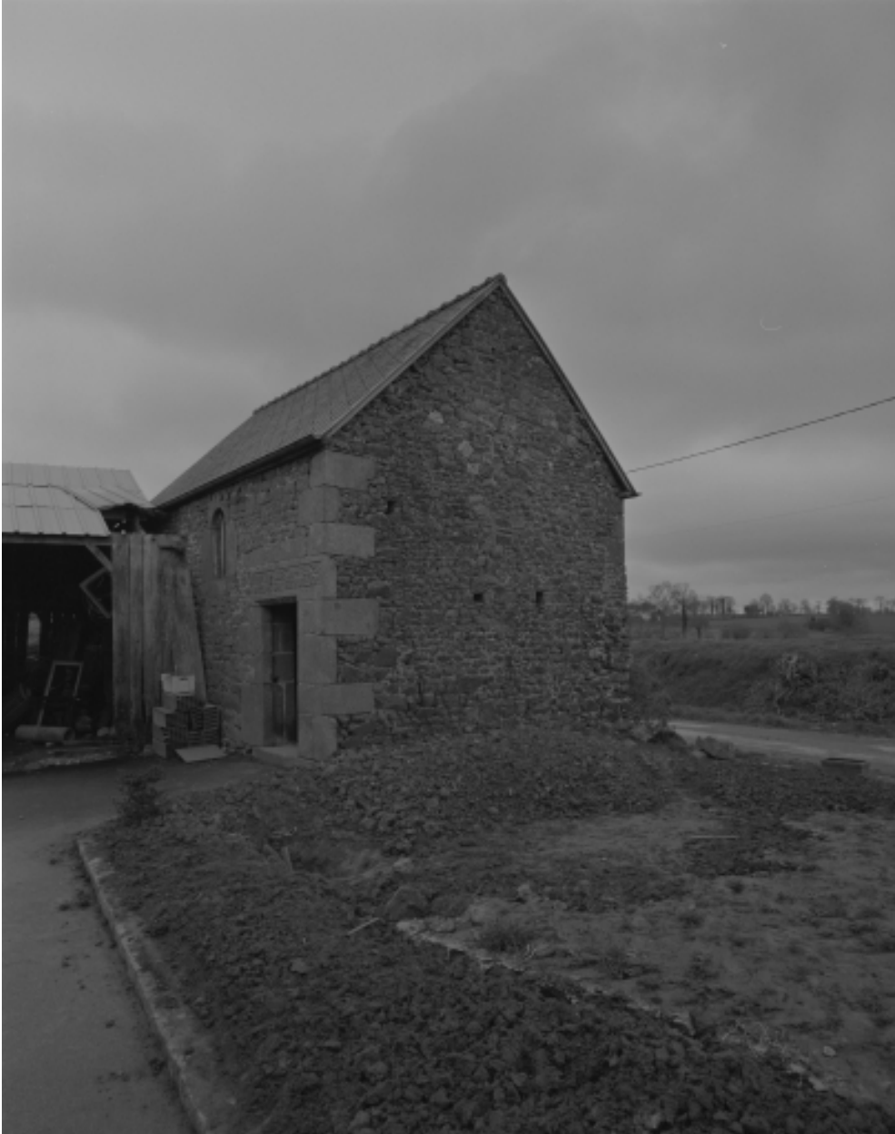
Elévation Ouest : vue générale
