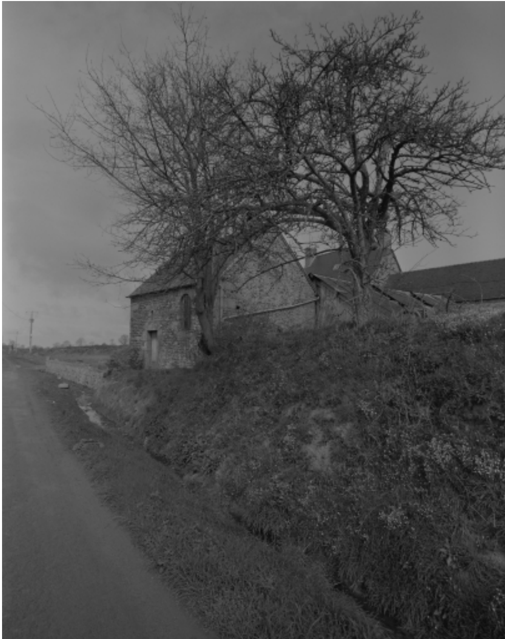
Elévation Est : vue de situation
