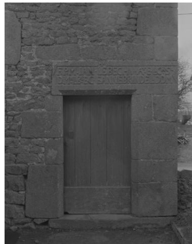
Elévation Nord, porte : vue générale
