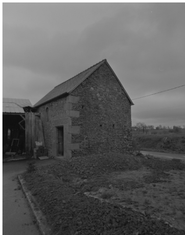
Elévation Ouest : vue générale
