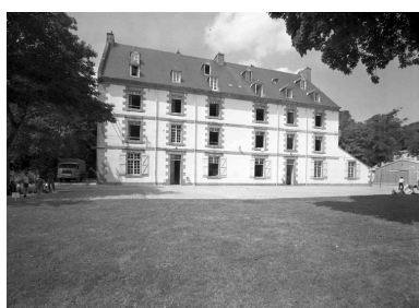
Vue générale de la caserne de Sourdis depuis le sud : élévation principale orientée vers l'est et la rade de Brest (état en 1971) Phot. Guy Artur IVR53_19692900311V
