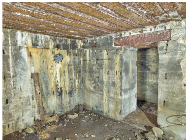
Vue de la pièce de vie - chambre Sud : contre le mur, vestiges du tuyau du poêle de forteresse ; au sol, arrivée des câbles ; au centre, emplacement du boîtier de connexion téléphonique. La porte donne accès à la petite pièce dédiée au périscopie
