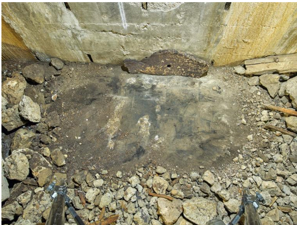
Vue de la pièce de vie - chambre Nord : détail du sol d'origine sous les gravats de béton et éclats de projectiles
