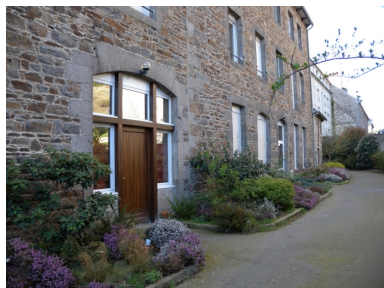
Vue de la façade postérieure : remarquer la porte cochère et les ouvertures secondaires Phot. Guy Prigent IVR53_20082213463NUCA
