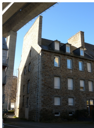
Vue de la façade postérieure du bâtiment : remarquer l'ancien espace dédié à un usage commercial Phot. Guy Prigent IVR53_20082213462NUCA
