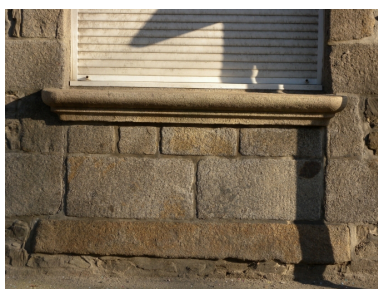
vue de détail du soubassement d'une ouverture avec encorbellement Phot. Guy Prigent IVR53_20082213458NUCA
