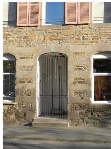
Vue de l'une des portes d'entrée de l'immeuble, avec son arc de décharge : la façade en moellons de schiste et les encadrements en pierre de granite Phot. Guy Prigent IVR53_20082213461NUCA
