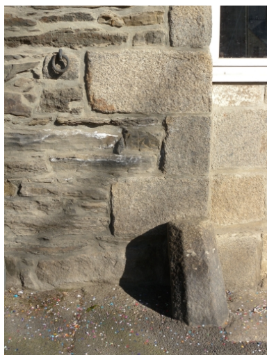
Vue de détail de l'ange antérieur droit, avec la borne de la porte cochère, les chaînes d'angle en pierre de taille et l'anneau pour attacher les chevaux Phot. Guy Prigent IVR53_20082213464NUCA
