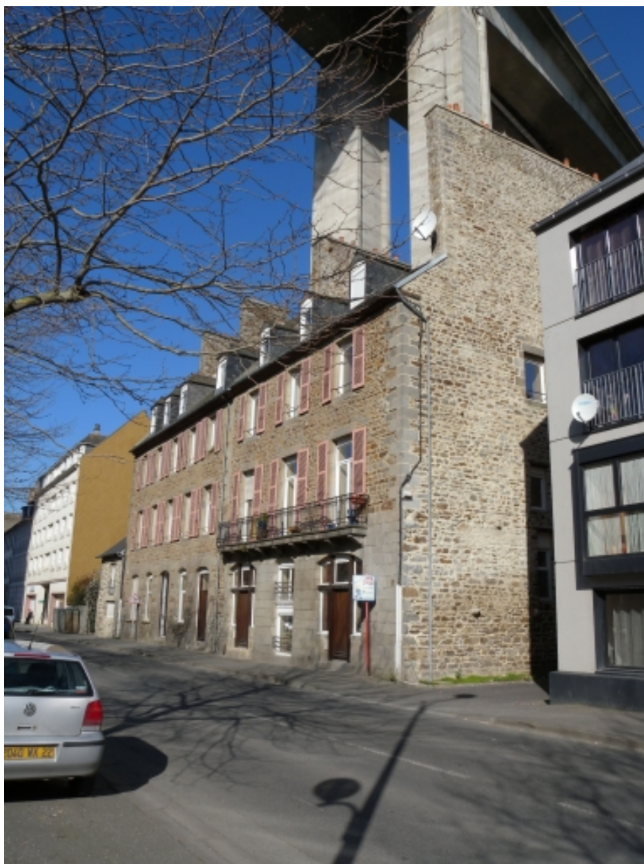
Vue de l'ensemble du bâtiment à plusieurs travées
