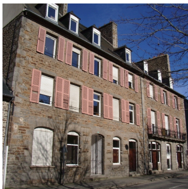
Vue d'ensemble de l'immeuble, ancienne maison d'armateur, transformée en logements Phot. Guy Prigent IVR53_20082212647NUCA
