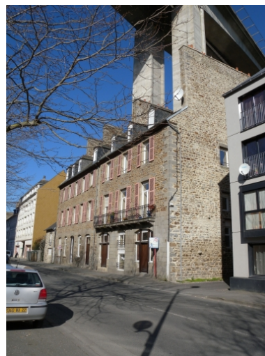
Vue de l'ensemble du bâtiment à plusieurs travées Phot. Guy Prigent IVR53_20082213465NUCA
