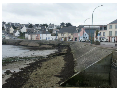
Vue générale du quai Kléber Phot. Agnès Galifot IVR53_20062908359NUCA
