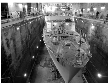
Vue intérieure de la base de sous-marins : navire en maintenance dans une alvéole à sec (2004) Phot. Guillaume Lécueillier IVR53_20042903986NUCA
