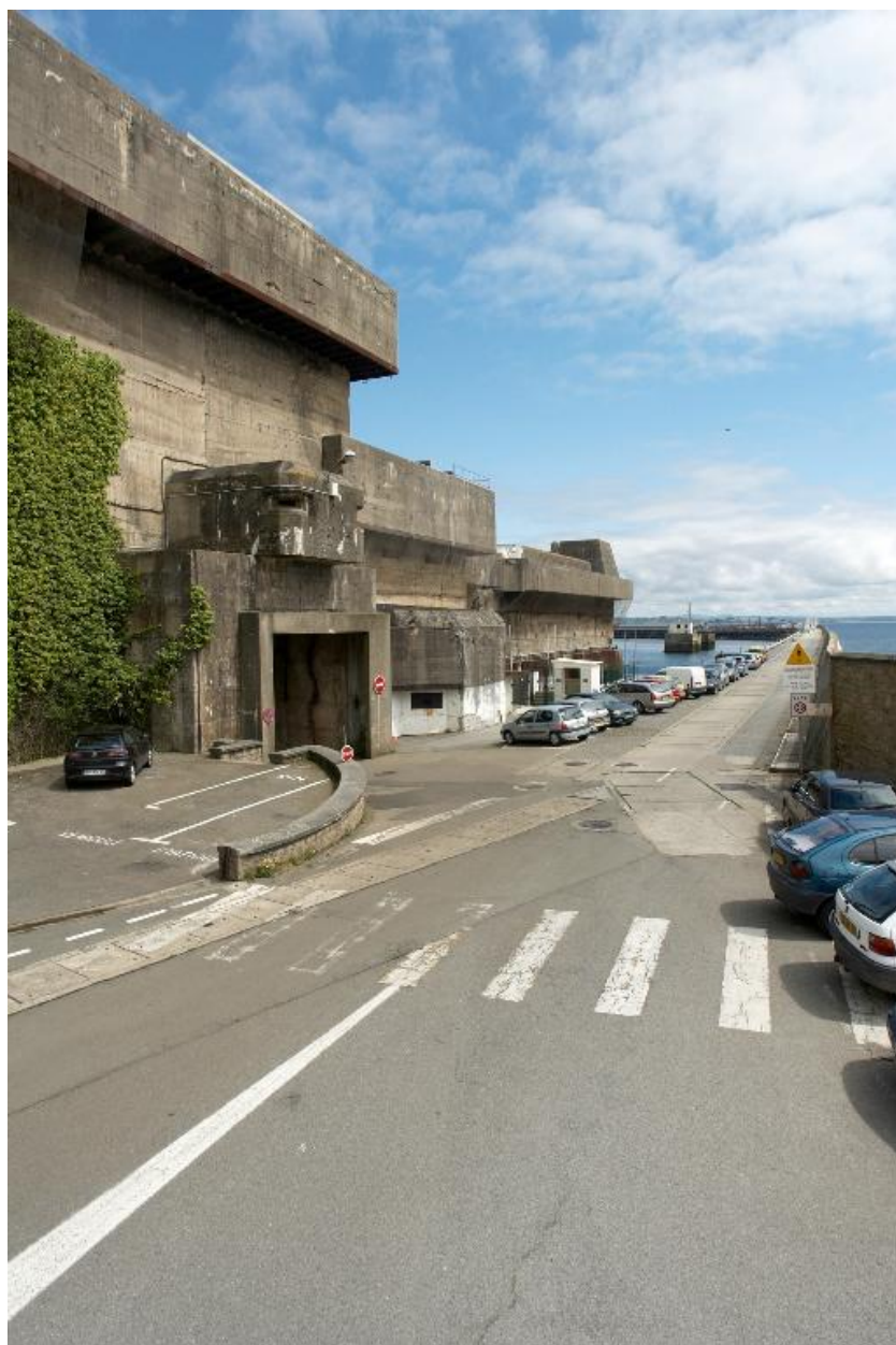
Vue de la base de sous-marins prise depuis l'intérieur de l'enceinte de l'arsenal : entrée ouest et abords
