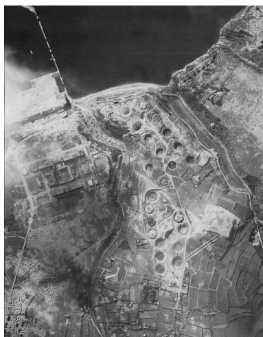
Vue aérienne verticale des ensembles fortifiés de l'école navale (Marineschule), de la base de sous-marins (U-Bootbunker) et du parc à carburants (Olberg). En haut à droite : le fort du Portzic Phot. Auteur inconnu IVR53_20062904773NUCA
