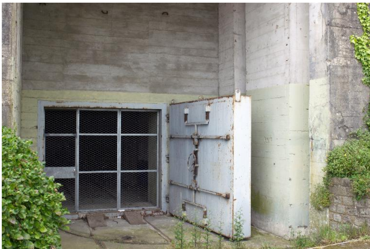
Vue du bunker-usine : détail de la porte blindée
