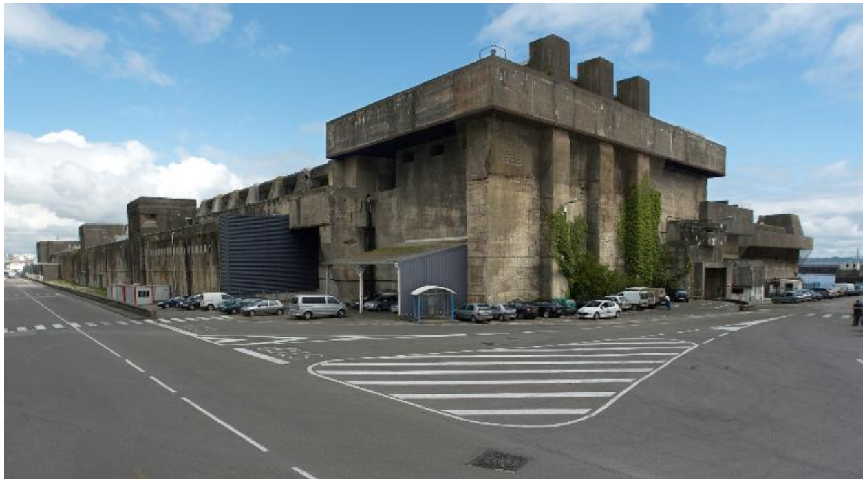
Vue de la base de sous-marins prise depuis l'intérieur de l'enceinte de l'arsenal : angle nord-ouest
