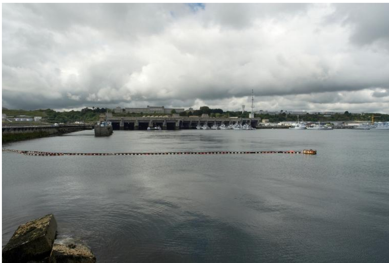
Vue générale de la base de sous-marins depuis l'intérieur de l'enceinte de l'arsenal
