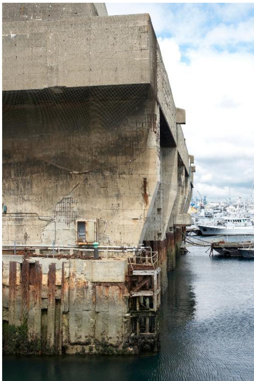
Vue de la base de sous-marins prise depuis l'intérieur de l'enceinte de l'arsenal : angle sud
