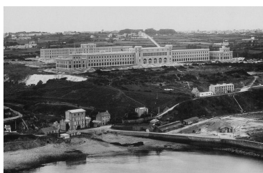
Vue aérienne oblique de l'école Navale de Brest, juin 1936. Au premier plan à droite, derrière la digue : le site de la future base de sous-marins Autr. L'Illustration IVR53_20042903946NUCA
