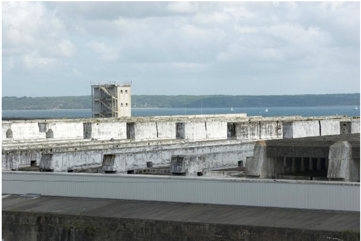
Vue de la base de sous-marins depuis la route de la Corniche : chambres d'explosion du toit
