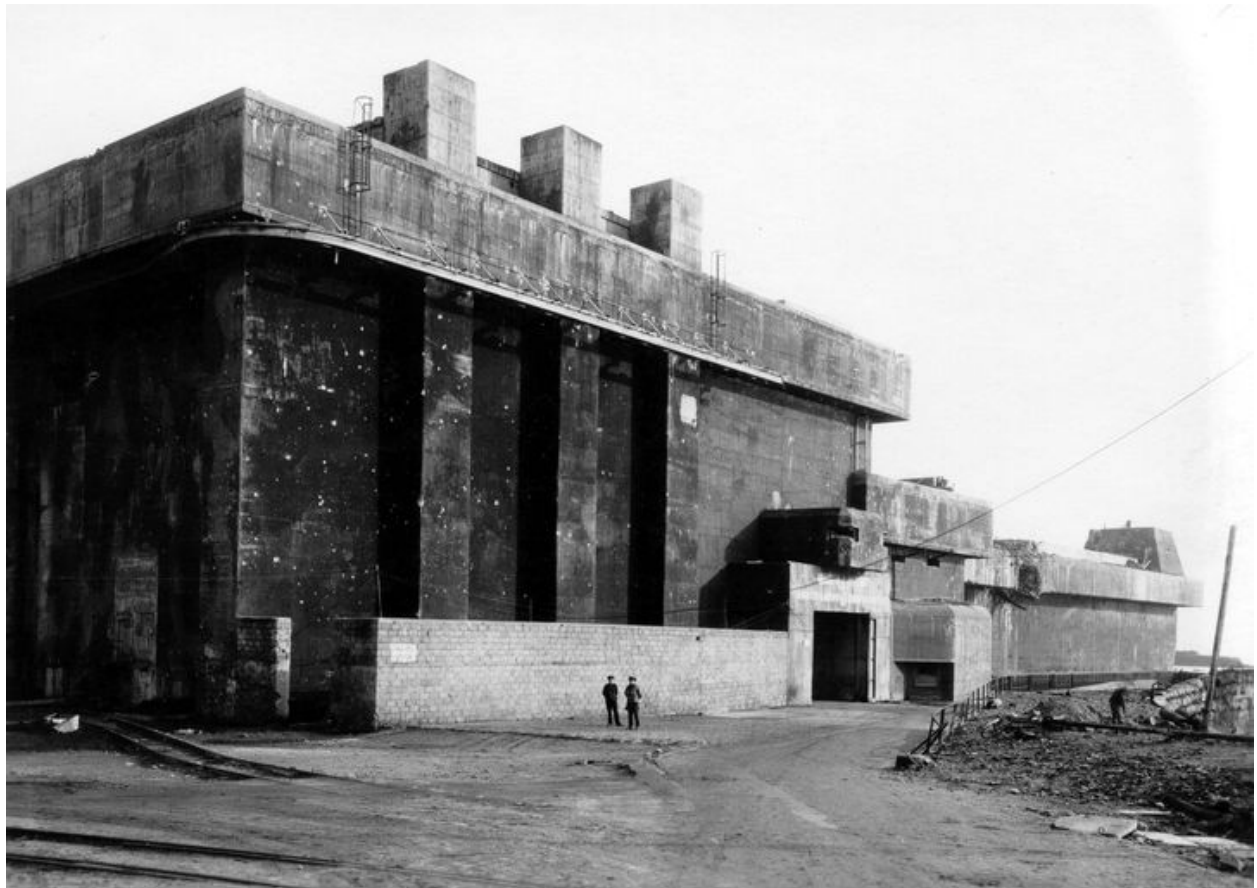
Vue de la base de sous-marins par le photographe Henri Chalois : entrée ouest et abords
