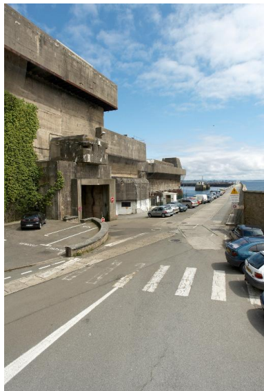
Vue de la base de sous-marins prise depuis l'intérieur de l'enceinte de l'arsenal : entrée ouest et abords Phot. Bernard Bègne IVR53_20122900994NUCA
