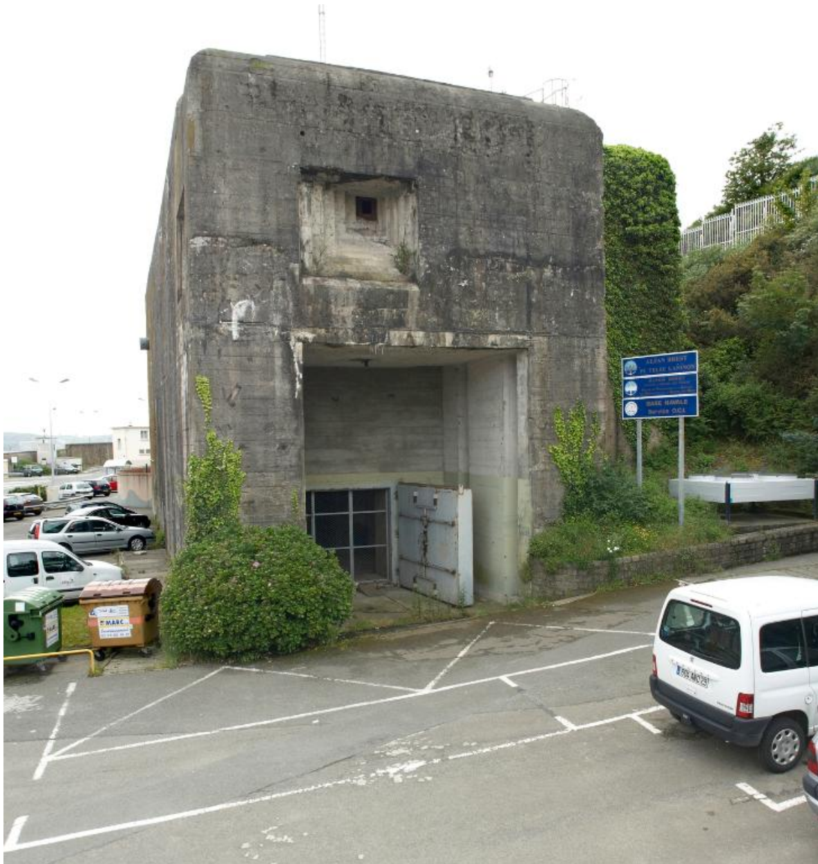
Vue du bunker-usine : entrée et porte blindée
