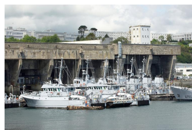
Vue de la base de sous-marins depuis l'intérieur de l'enceinte de l'arsenal : détail du front sud-est. Au premier plan, navires à quai. L'Altair et le Aldébaran sont deux bâtiments remorqueurs de sonars Phot. Bernard Bègne IVR53_20122900982NUCA
