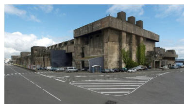
Vue de la base de sous-marins prise depuis l'intérieur de l'enceinte de l'arsenal : angle nord-ouest Phot. Bernard Bègne IVR53_20122900996NUCA
