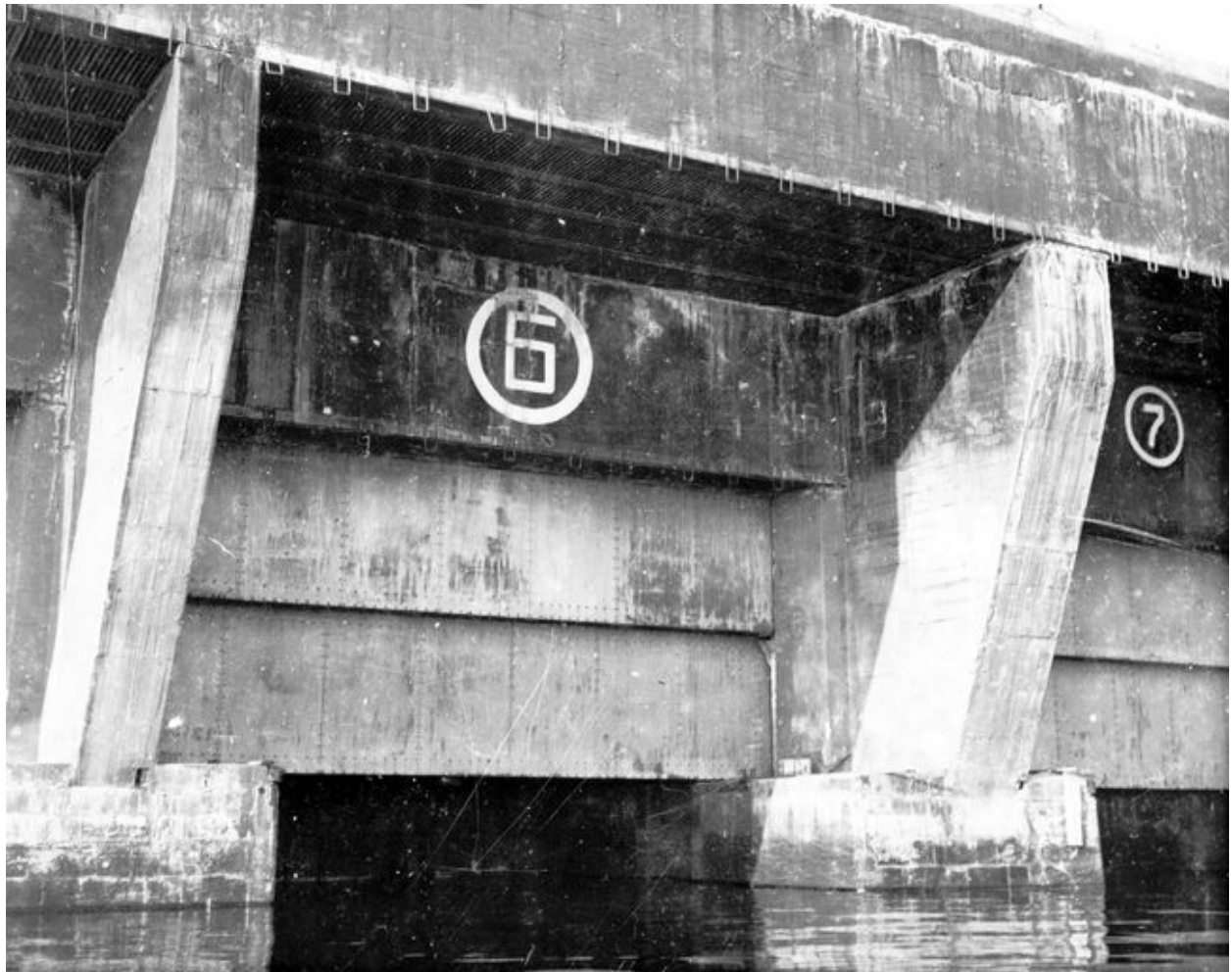
Vue de la base de sous-marins : entrée de l'alvéole n° 6
