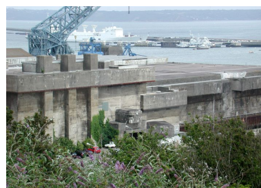
Vue de la base de sous-marins depuis les abords du parc à carburant Phot. Guillaume Lécueillier IVR53_20042903799NUCA
