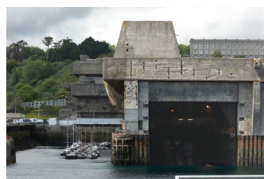
Vue de détail prise depuis l'intérieur de l'enceinte de l'arsenal Phot. Bernard Bègne IVR53_20122900985NUCA
