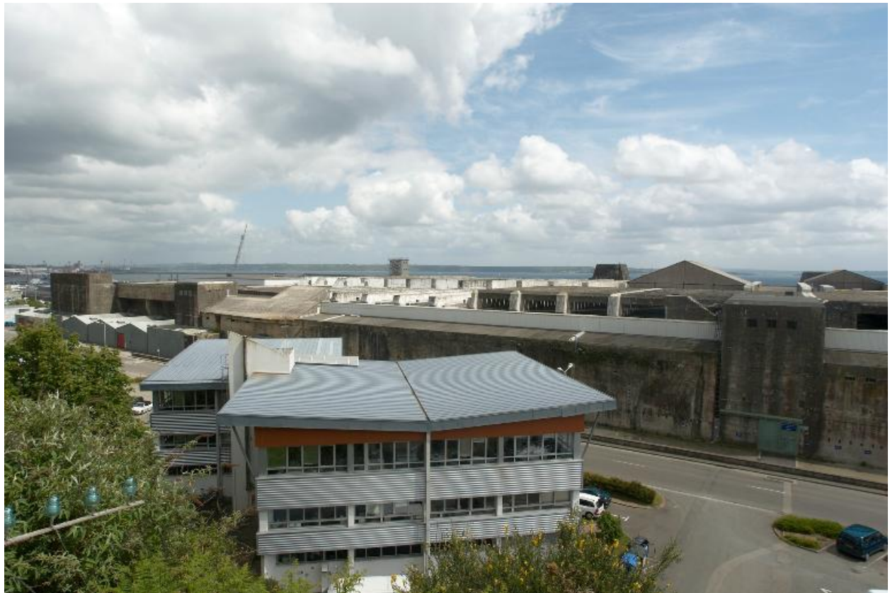
Vue de la base de sous-marins depuis la route de la Corniche : chambres d'explosion du toit. Au premier plan, bâtiment moderne
