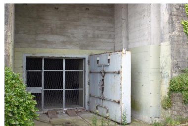
Vue du bunker-usine : détail de la porte blindée Phot. Bernard Bègne IVR53_20122901000NUCA
