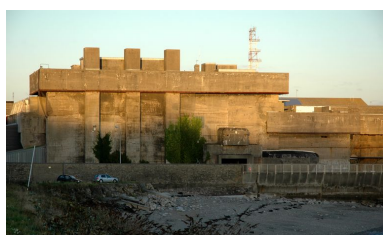
Vue de la base de sous-marins : détail du front sud-ouest Phot. Guillaume Lécueillier IVR53_20042904068NUCA
