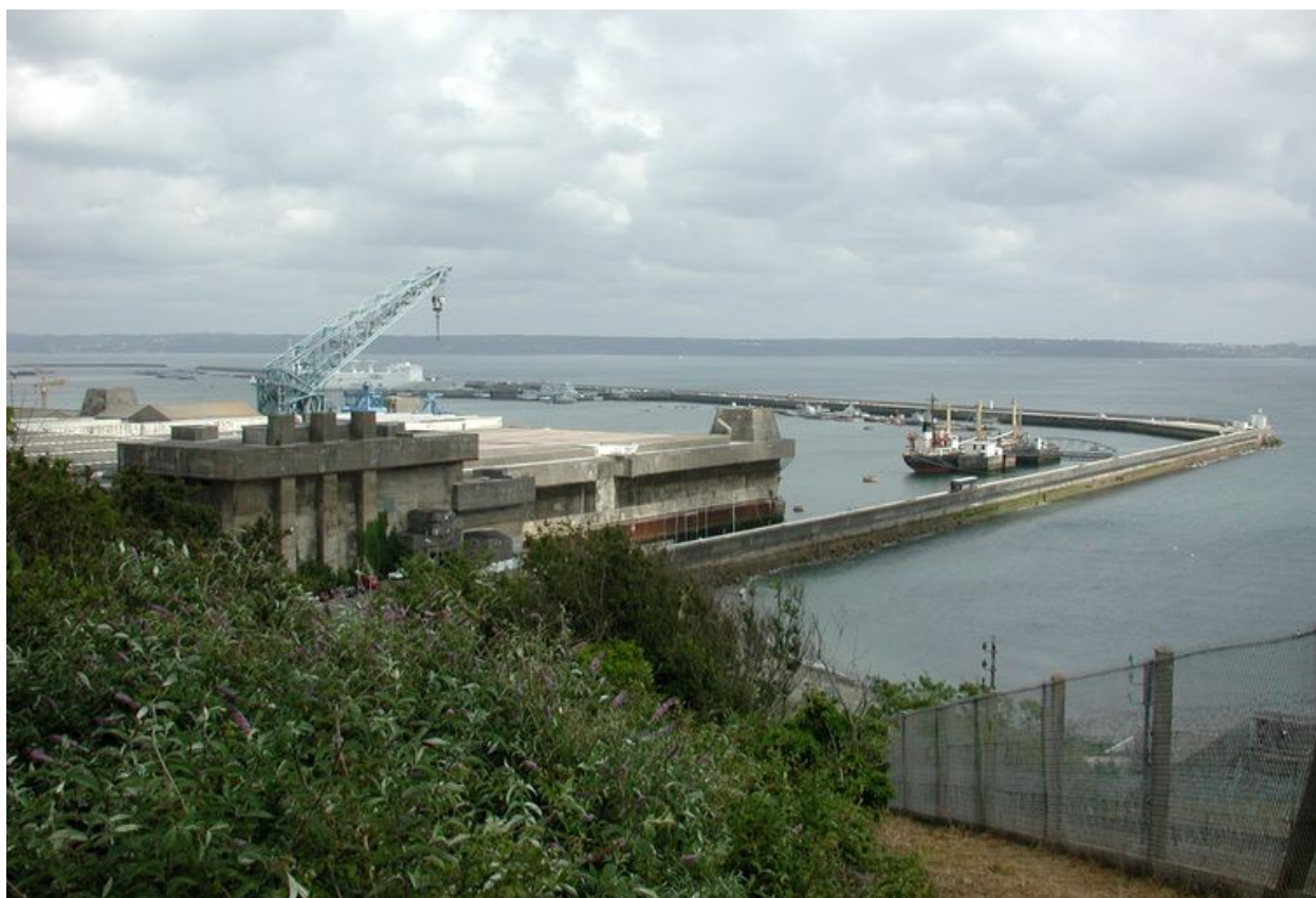
Vue de situation de la base de sous-marins depuis les abords du parc à carburant
