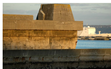
Vue de la base de sous-marins : détail du front sud-ouest, cuve de défense pour canons antiaériens Phot. Guillaume Lécueillier IVR53_20042904070NUCA
