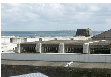
Vue de la base de sous-marins depuis la route de la Corniche : chambres d'explosion du toit Phot. Bernard Bègne IVR53_20122901001NUCA
