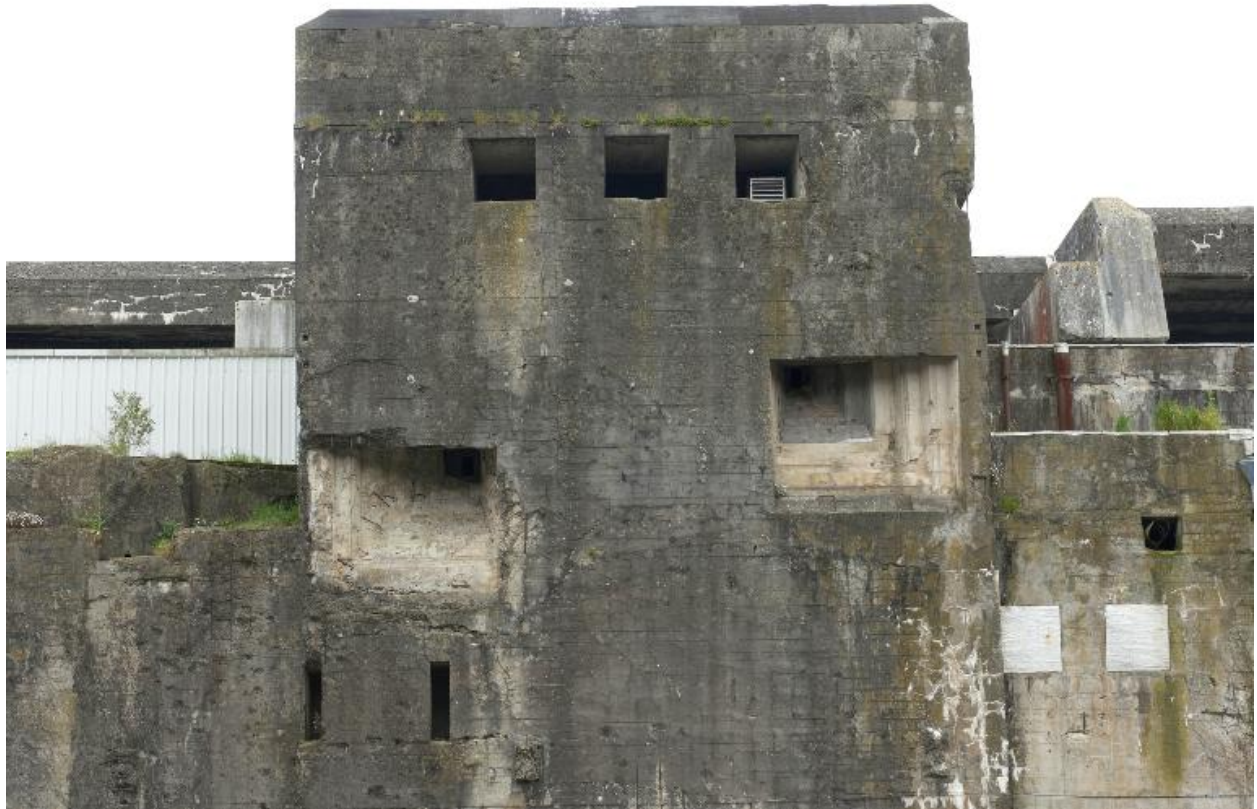
Vue de la base de sous-marin prise depuis l'intérieur de l'enceinte de l'arsenal : front nord-ouest, tour crénelée
