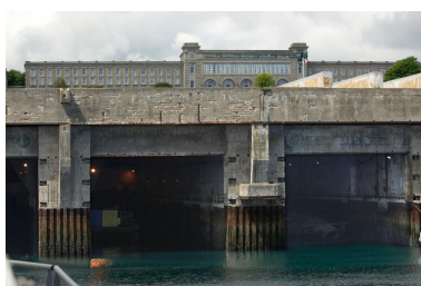
Vue de détail prise depuis l'intérieur de l'enceinte de l'arsenal Phot. Bernard Bègne IVR53_20122900984NUCA
