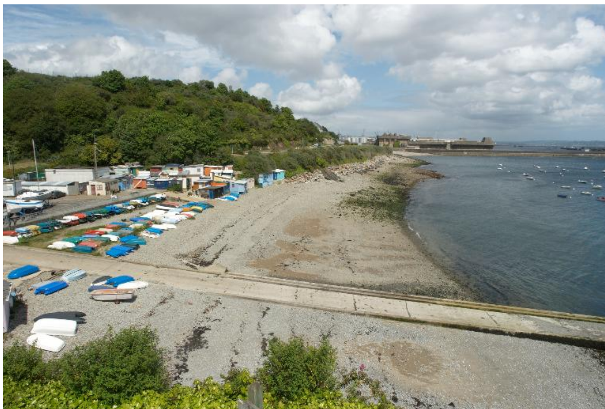
Vue de situation de la base de sous-marins depuis Maison Blanche (sur l'emplacement de la casemate de type 515)
