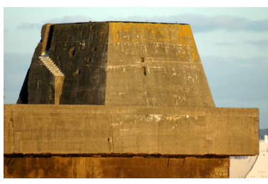
Vue de la base de sous-marins : détail du front sud-ouest, cuve de défense pour canons antiaériens Phot. Guillaume Lécueillier IVR53_20042904071NUCA
