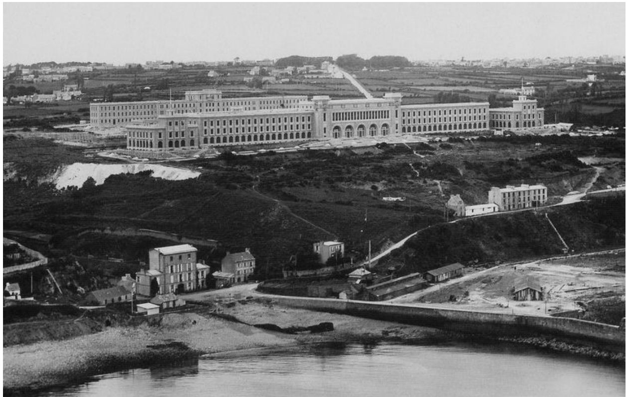
Vue aérienne oblique de l'école Navale de Brest, juin 1936. Au premier plan à droite, derrière la digue : le site de la future base de sous-marins
