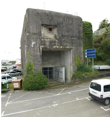
Vue du bunker-usine : entrée et porte blindée
