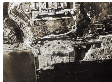
Vue aérienne verticale des ensembles fortifiés de la base de sous-marins (U-Bootbunker) et de l'école navale (Marineschule). A droite de la base de sous-marins : les fondations de l'extension est Autr. Anonyme IVR53_20042903977NUCA
