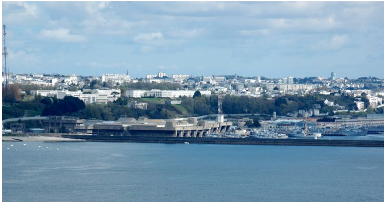
Vue d'ensemble de la ville de Brest depuis la pointe des Espagnols à Roscanvel : la rade abri de l'arsenal et la base de sous-marins
