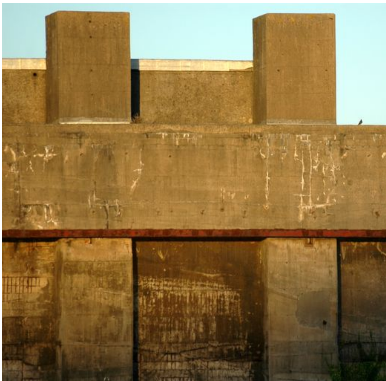
Vue de la base de sous-marins : détail du front sud-ouest, dalle de couverture
