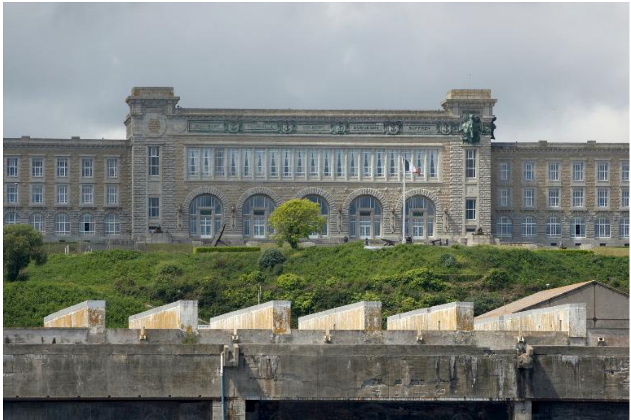
Vue du centre d'instruction naval. Au premier plan, la dalle de couverture de la base de sous-marins
