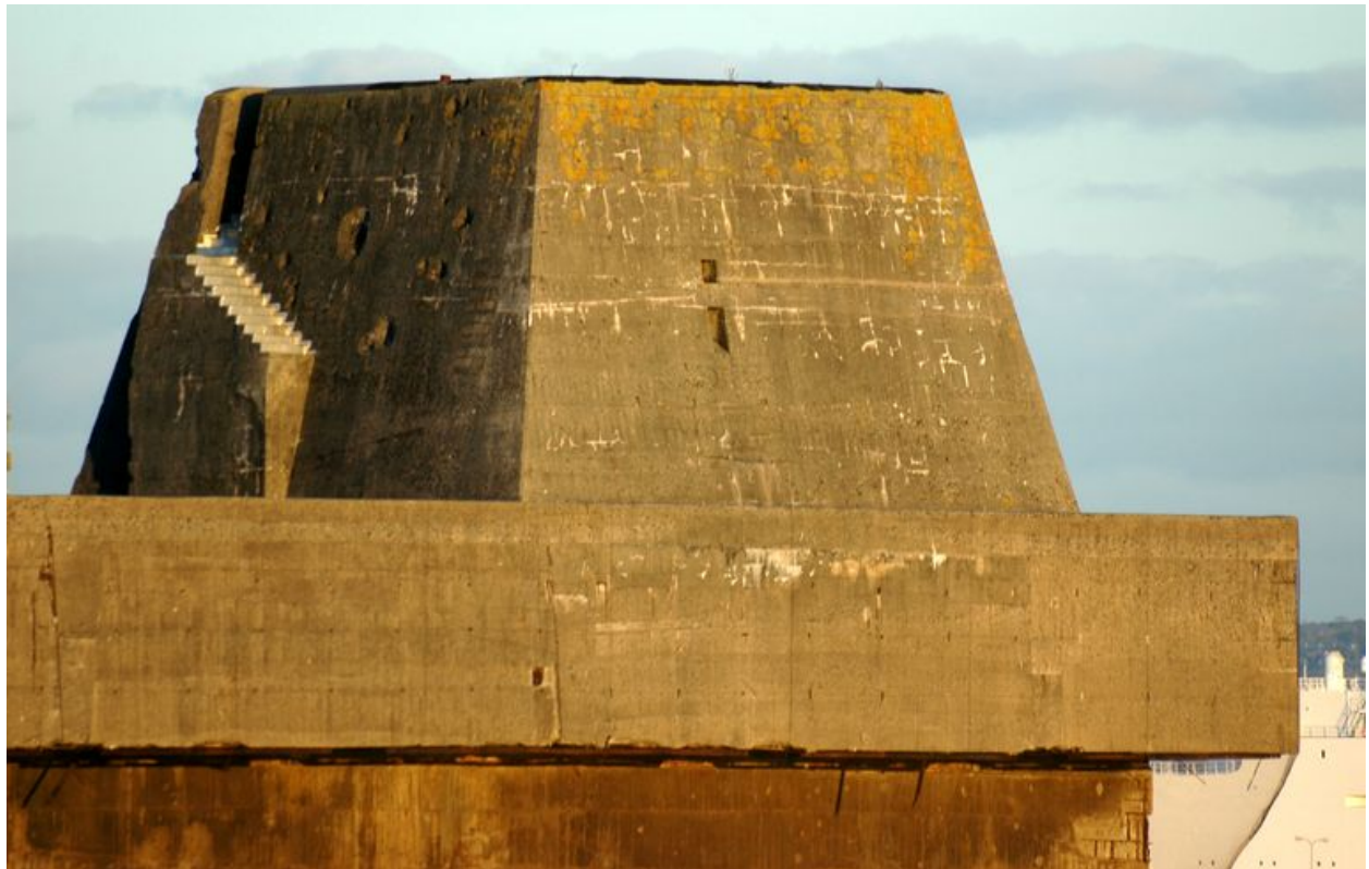
Vue de la base de sous-marins : détail du front sud-ouest, cuve de défense pour canons antiaériens
