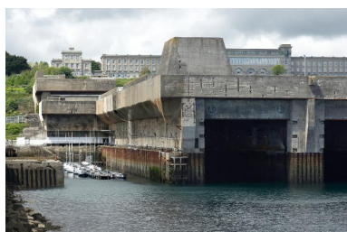
Vue de la base de sous-marins depuis l'intérieur de l'enceinte de l'arsenal : angle sud du front sud-est Phot. Bernard Bègne IVR53_20122900976NUCA
