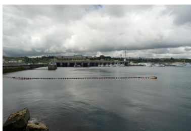
Vue générale de la base de sous-marins depuis l'intérieur de l'enceinte de l'arsenal Phot. Bernard Bègne IVR53_20122900988NUCA
