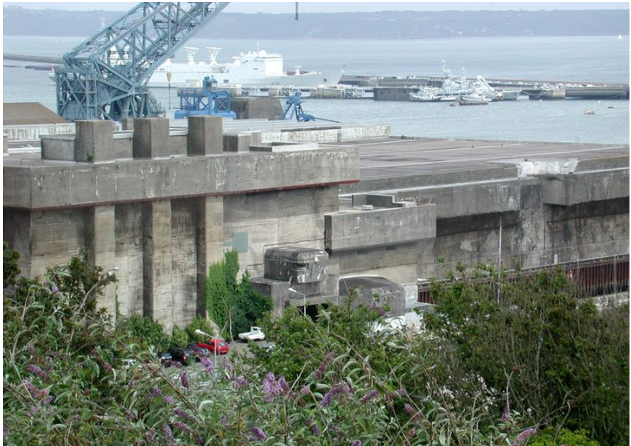
Vue de la base de sous-marins depuis les abords du parc à carburant
