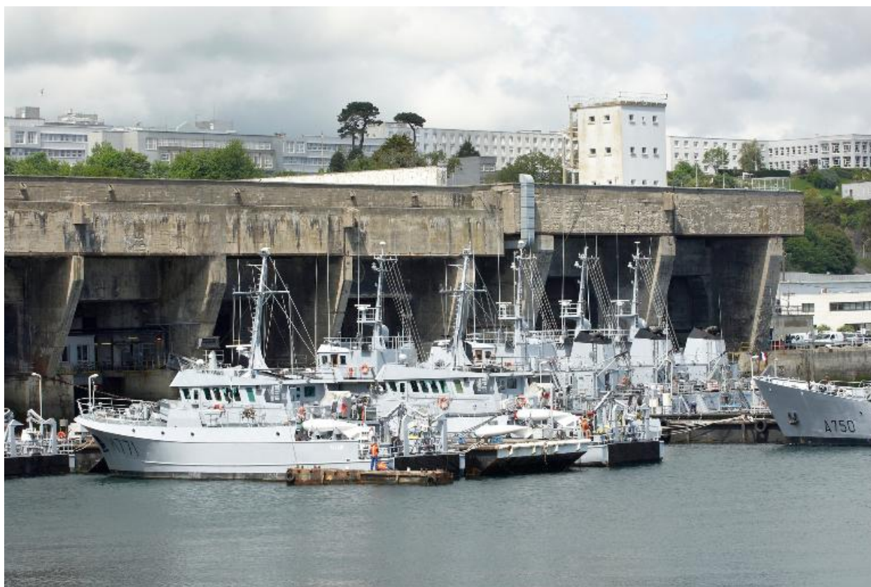
Vue de la base de sous-marins depuis l'intérieur de l'enceinte de l'arsenal : détail du front sud-est. Au premier plan, navires à quai. L'Altair et le Aldébaran sont deux bâtiments remorqueurs de sonars
