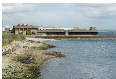
Vue générale de la base de sous-marins depuis Maison Blanche : front sud-ouest Phot. Bernard Bègne IVR53_20122901007NUCA
