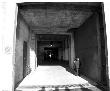
Vue intérieure de la base de sous- marins : entrée ouest (2004) Phot. Guillaume Lécueillier IVR53_20042903802NUCA
