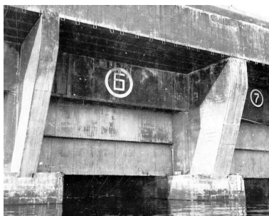
Vue de la base de sous-marins : entrée de l'alvéole n° 6 Repro. Archives municipales et communautaires. Brest Métropole Océane, Phot. Guillaume (retouche) Lécueillier, Autr. D.C.A.N. Brest IVR53_20082909062NUC
