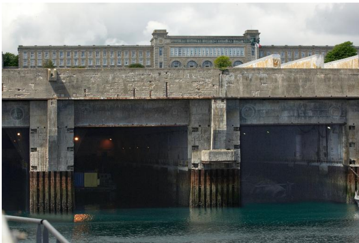
Vue de détail prise depuis l'intérieur de l'enceinte de l'arsenal
