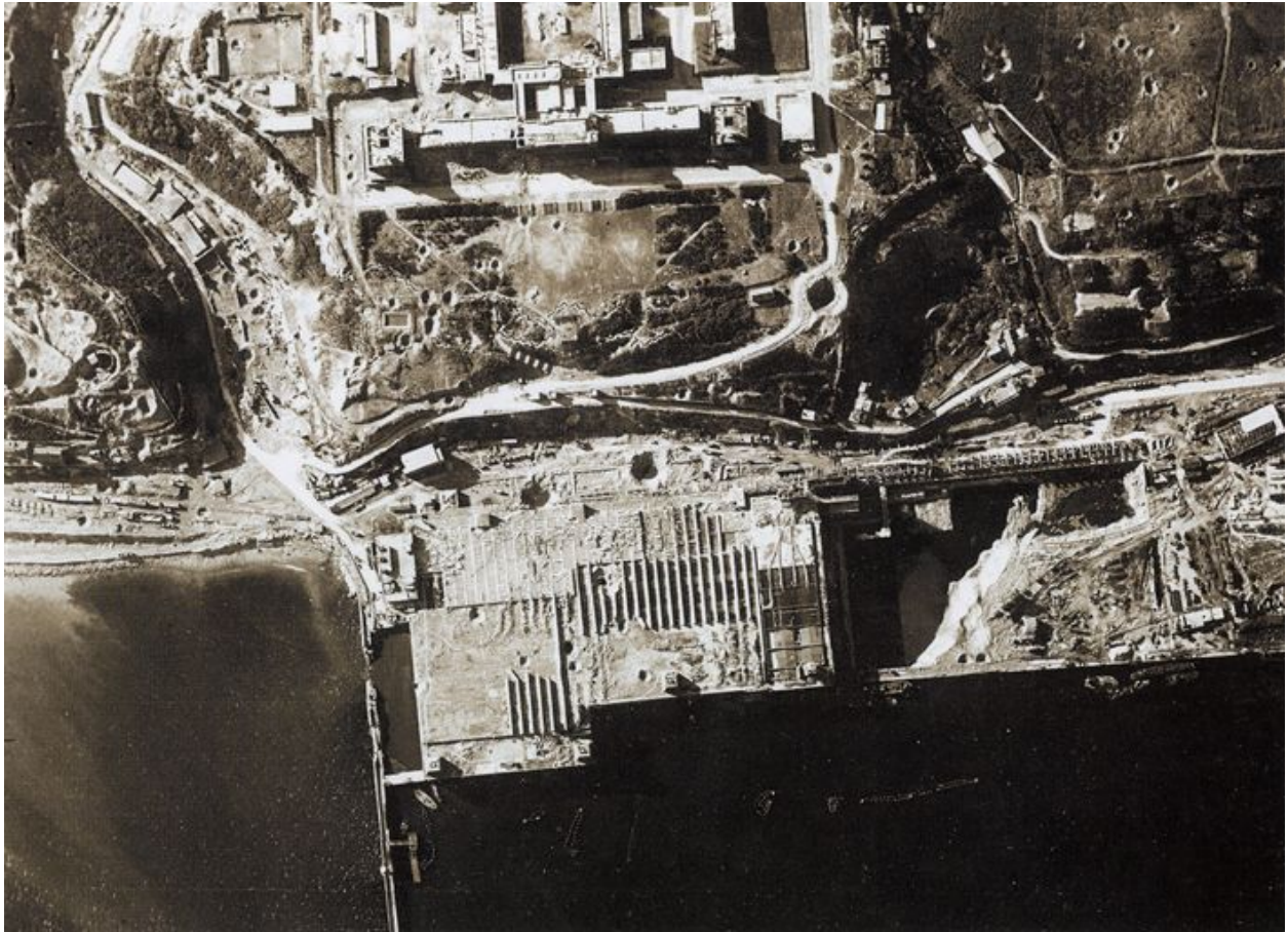
Vue aérienne verticale des ensembles fortifiés de la base de sous-marins (U-Bootbunker) et de l'école navale (Marineschule). A droite de la base de sous-marins : les fondations de l'extension est
