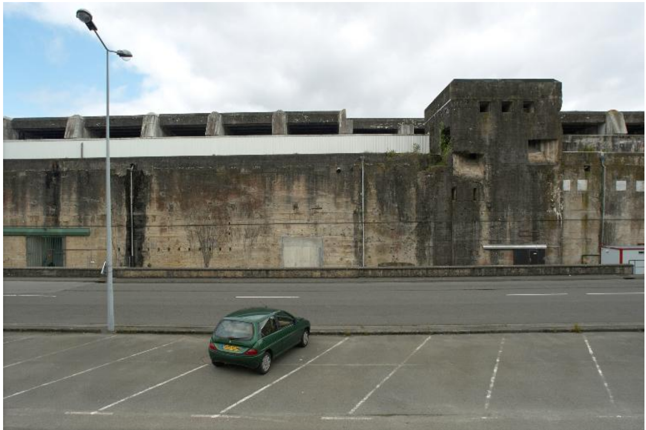
Vue de la base de sous-marin prise depuis l'intérieur de l'enceinte de l'arsenal : front nord-ouest, tour crénelée
