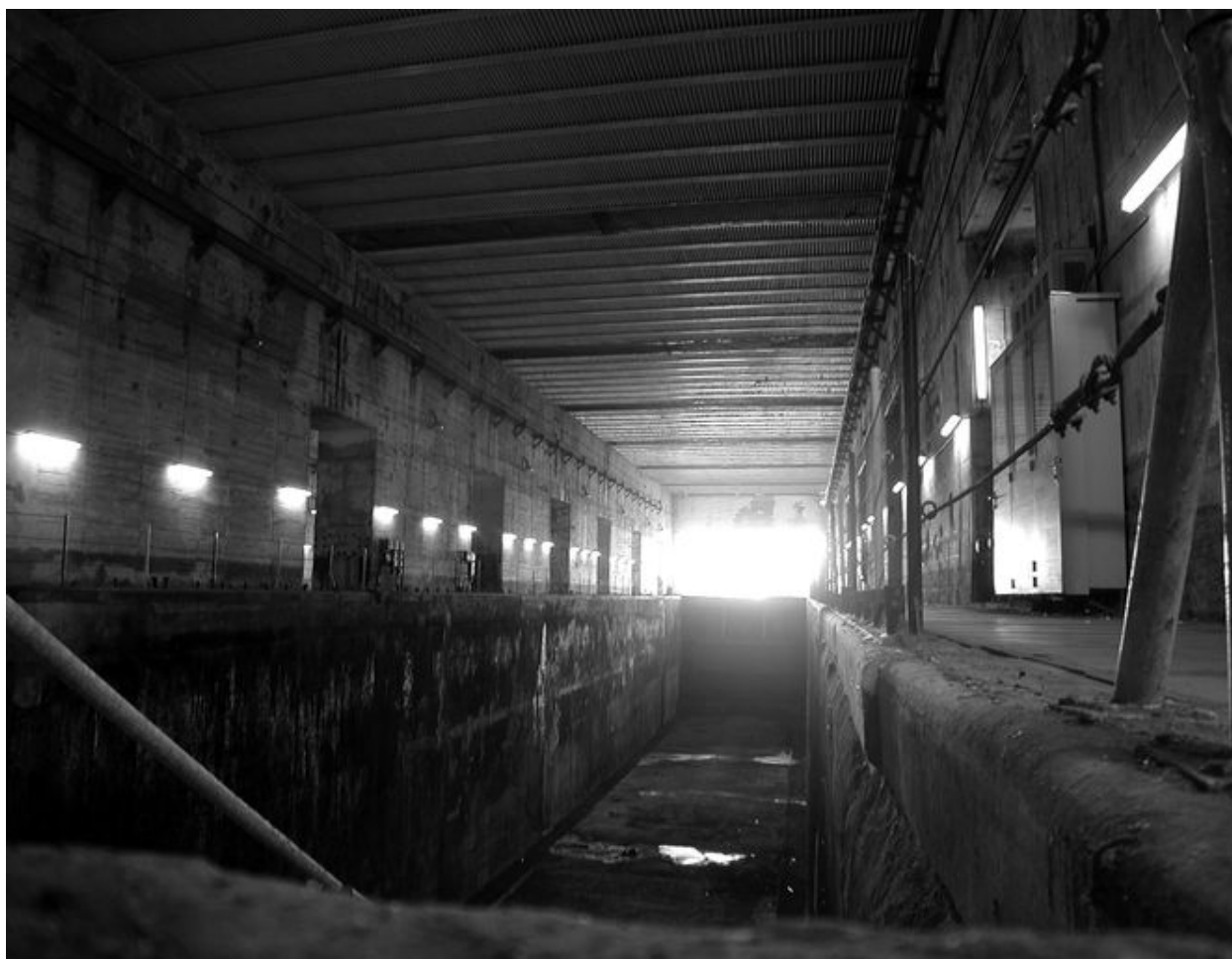
Vue intérieure de la base de sous-marins : alvéole à sec (2004)
