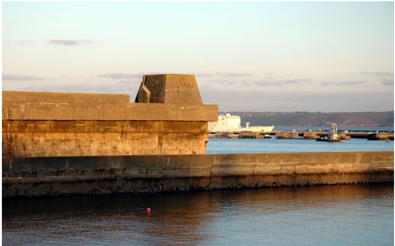
Vue de la base de sous-marins : détail du front sud-ouest, cuve de défense antiaérienne
