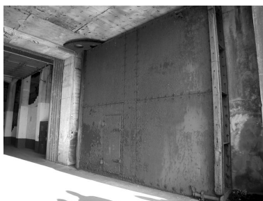
Vue intérieure de la base de sous-marins : porte blindée de l'entrée ouest (2004) Phot. Guillaume Lécueillier IVR53_20042903803NUCA
