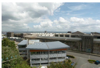
Vue de la base de sous-marins depuis la route de la Corniche : chambres d'explosion du toit. Au premier plan, bâtiment moderne Phot. Bernard Bègne IVR53_20122901003NUCA
