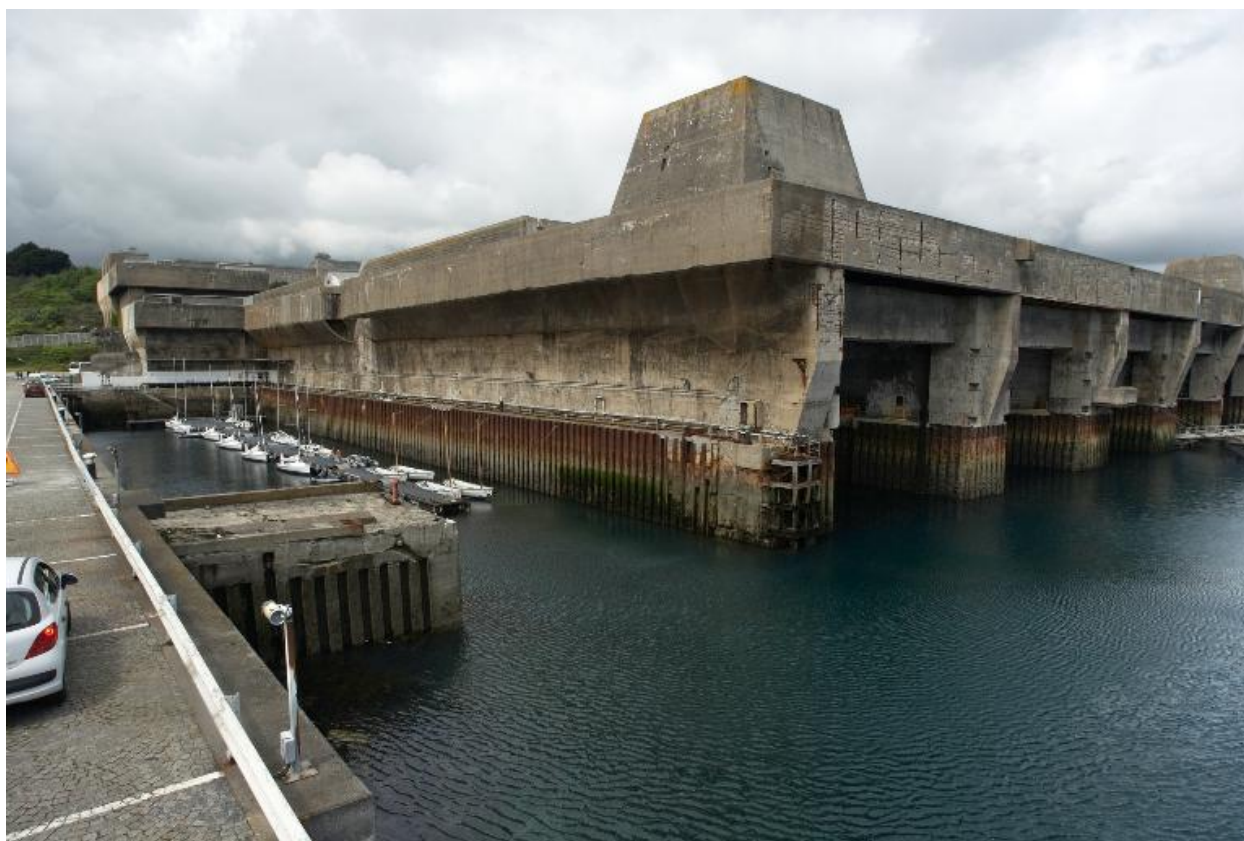
Vue de la base de sous-marins prise depuis l'intérieur de l'enceinte de l'arsenal : angle sud
