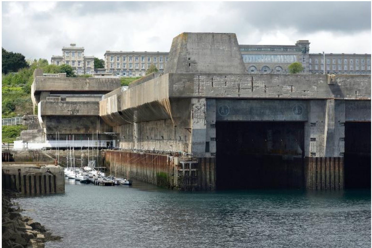
Vue de la base de sous-marins depuis l'intérieur de l'enceinte de l'arsenal : angle sud du front sud-est
