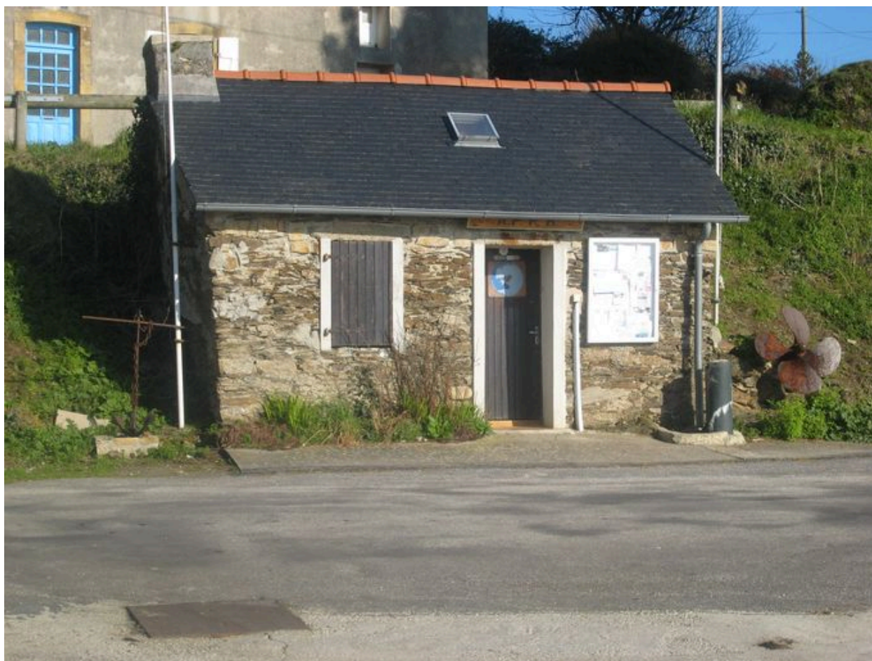
Vue générale de la maison du douanier
