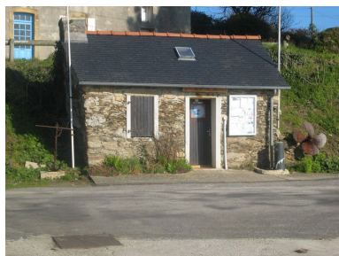
Vue générale de la maison du douanier Phot. Françoise Péron IVR53_20072908936NUCA
