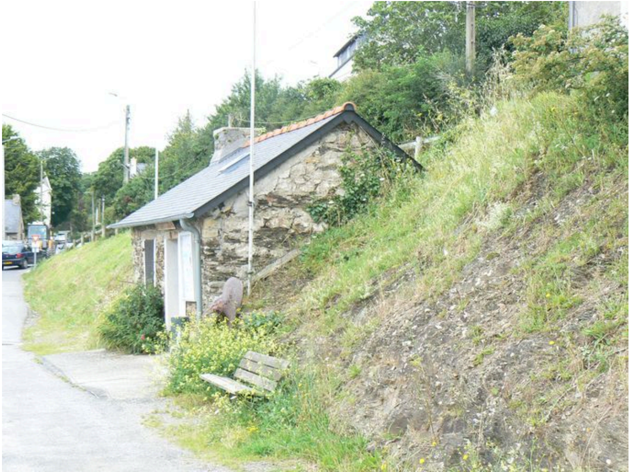
Vue latérale de la maison du douanier
