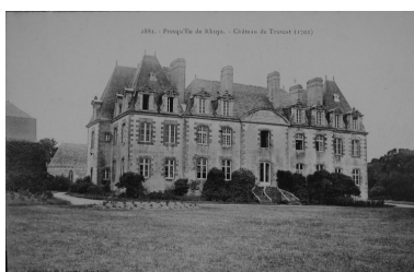
Vue de la façade principale Autr. Henri Laurent IVR53_20035604289NUCB
