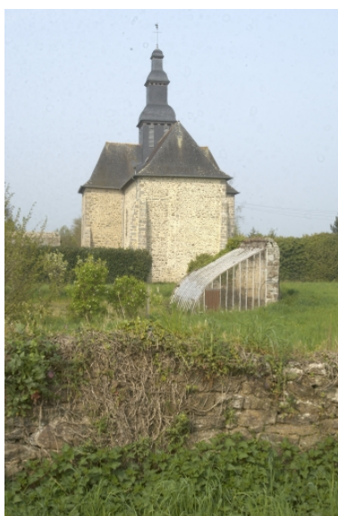
Vue est Phot. Norbert Lambart IVR53_20073500557NUCA
