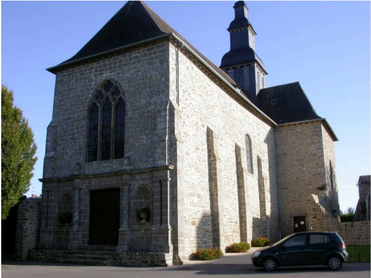
Vus sud-ouest de l'église
