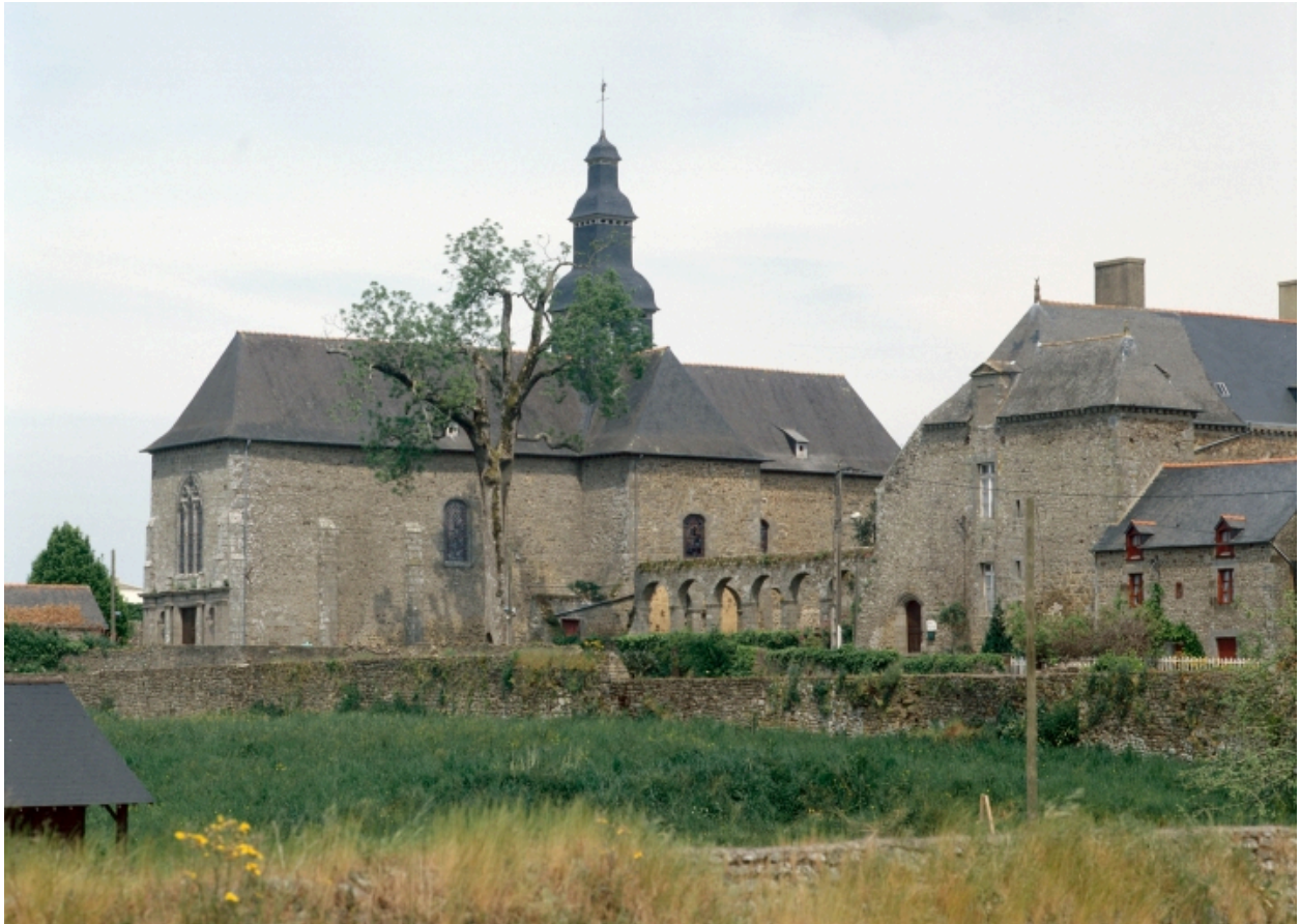
Elévation Sud : vue générale
