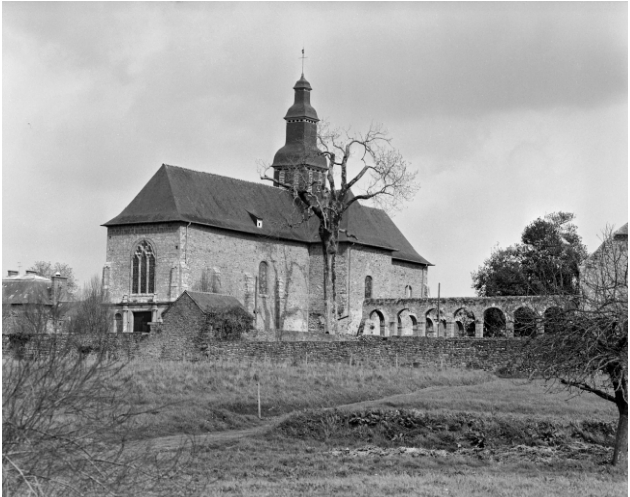
Elévation Sud-Ouest : vue de situation
