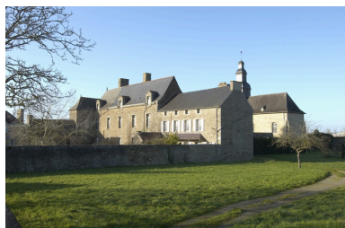
Vue sud-est Phot. Norbert Lambart IVR53_20063502695NUCA
