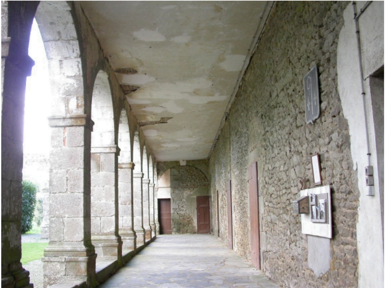
Partie sud du cloître
