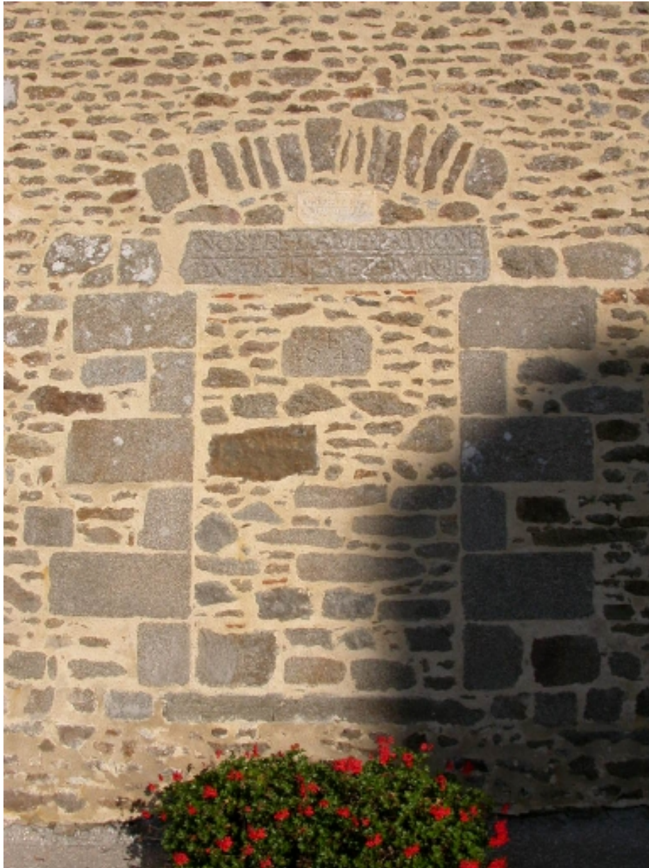
Baie murée de la façade sud
