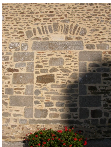
Baie murée de la façade sud Phot. Sabrina Dalibard
