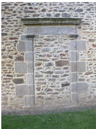
Baie murée, mur sud Phot. Sabrina Dalibard IVR53_20063513959NUCA
