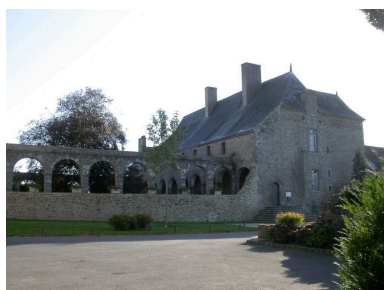
Vue nord-ouest Phot. Sabrina Dalibard IVR53_20063513945NUCA
