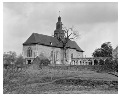
Elévation Sud-Ouest : vue de situation Phot. Guy Artur, Phot. Norbert Lambart IVR53_19943500758X
