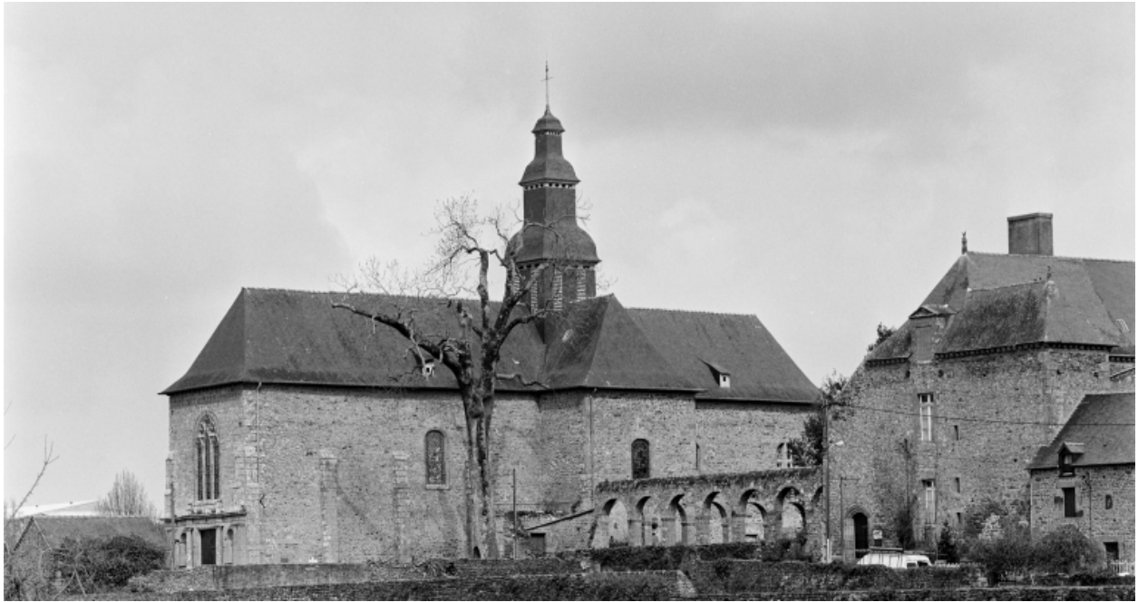
Elévation Sud : vue générale
