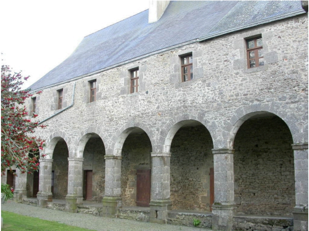
Partie sud du cloître
