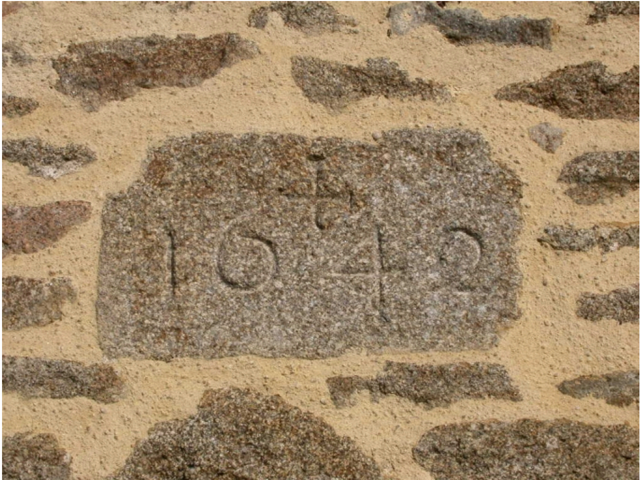
Détail de la date, 1642
