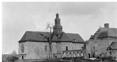
Elévation Sud : vue générale Phot. Guy Artur, Phot. Norbert Lambart IVR53_19943500759X
