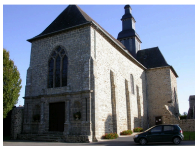
Vus sud-ouest de l'église Phot. Sabrina Dalibard IVR53_20063513952NUCA
