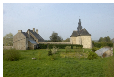
Vue est Phot. Norbert Lambart IVR53_20073500558NUCA
