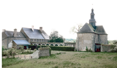
Elévation Est : vue générale Phot. Guy Artur, Phot. Norbert Lambart IVR53_19953500260XA
