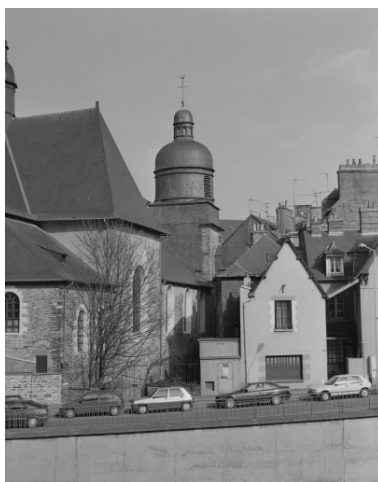
Elévation Ouest, clocher : vue générale
