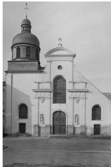
Elévation Est : vue générale.
