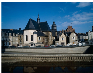
Elévation ouest : vue de situation
