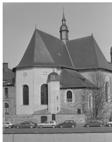
Elévation Ouest : vue générale
