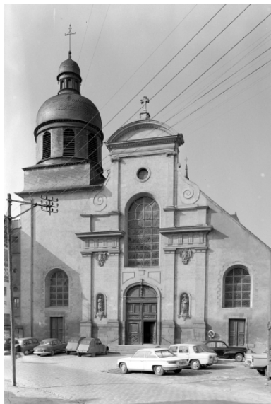
Rennes - Eglise Saint-Etienne - Elévation est, vue générale.
