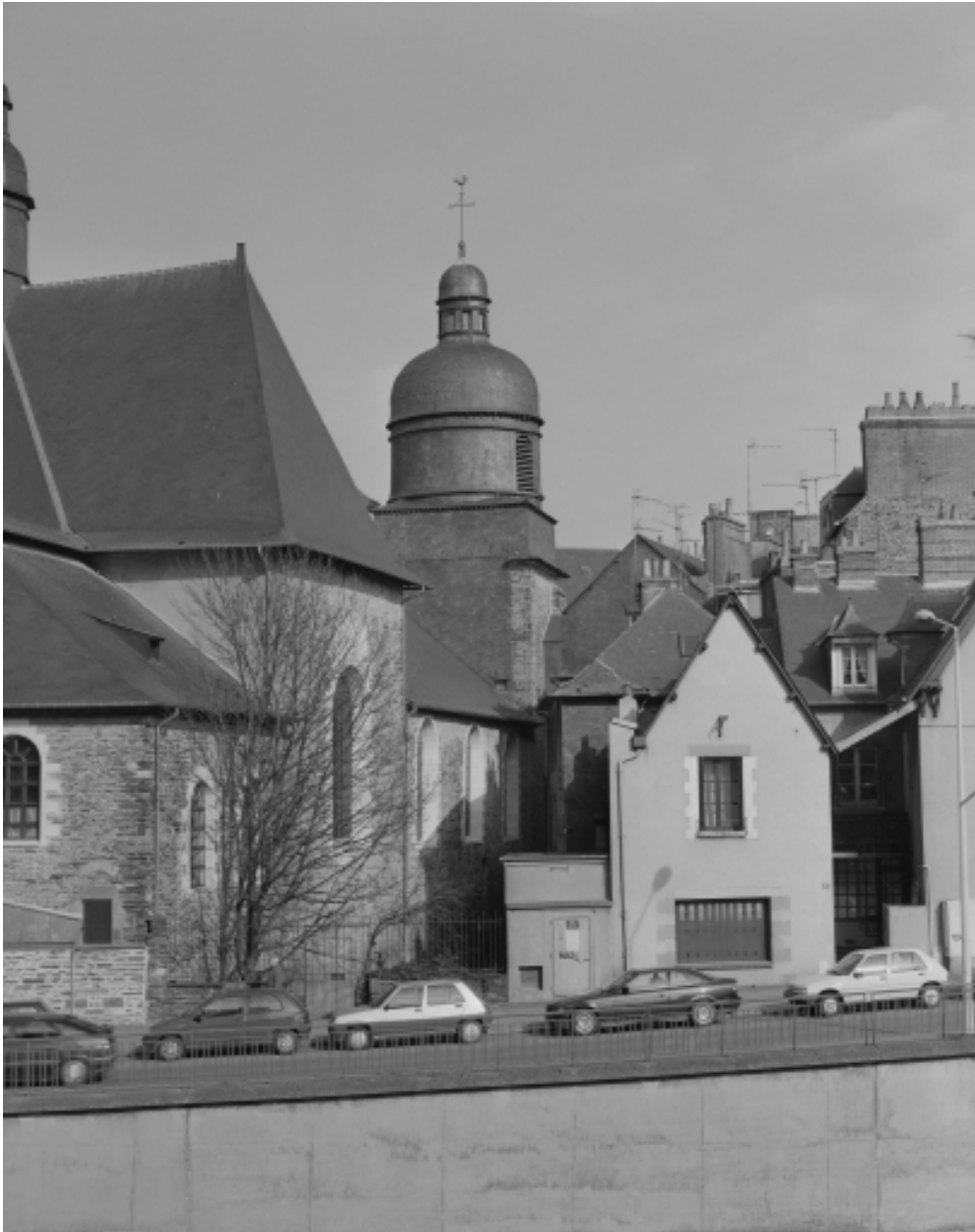
Elévation Ouest, clocher : vue générale
