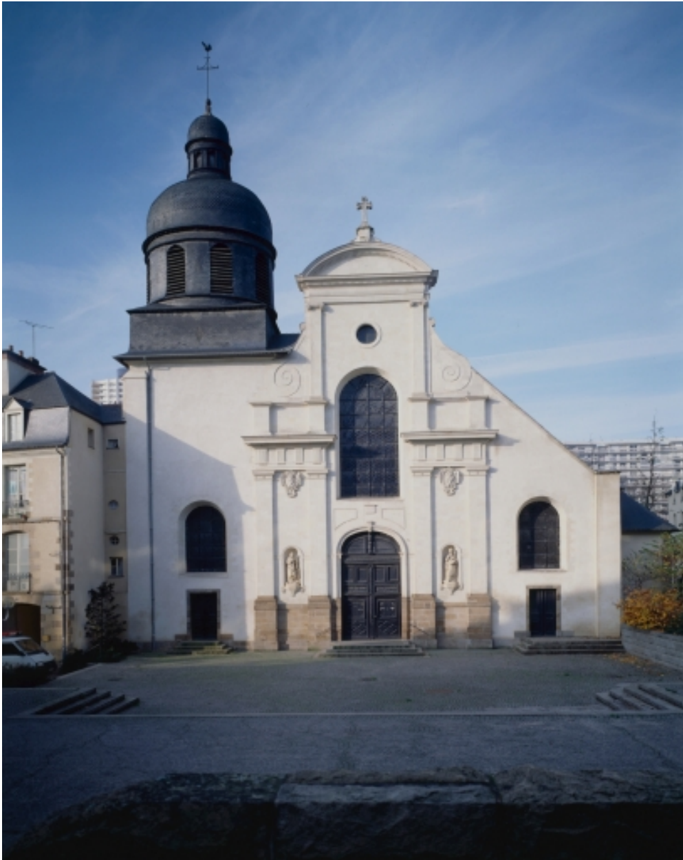
Elévation Est : vue générale
