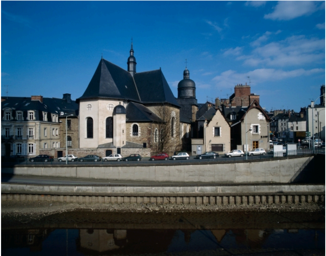
Elévation ouest : vue de situation
