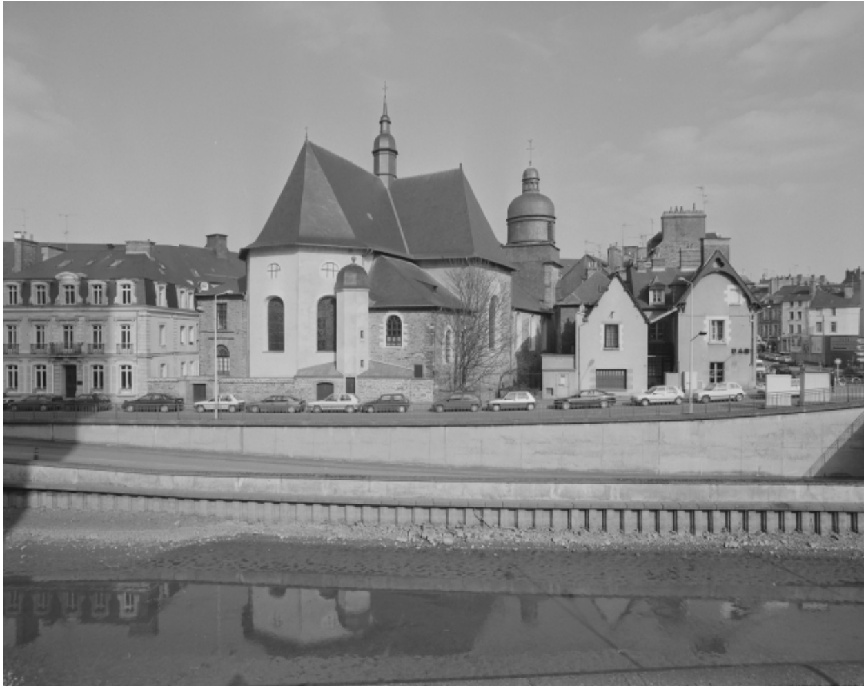
Elévation Ouest : vue de situation
