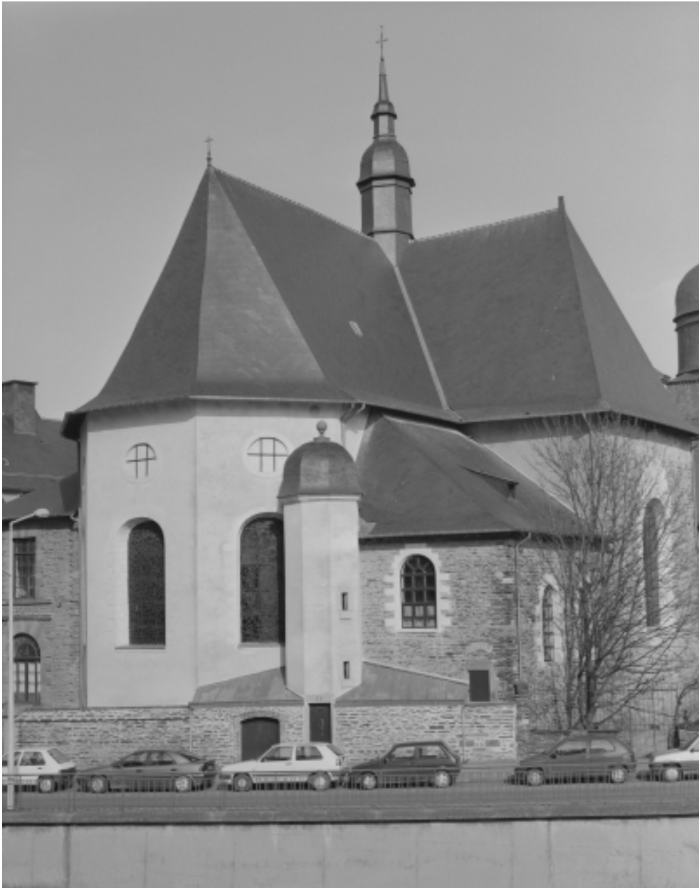
Elévation Ouest : vue générale
