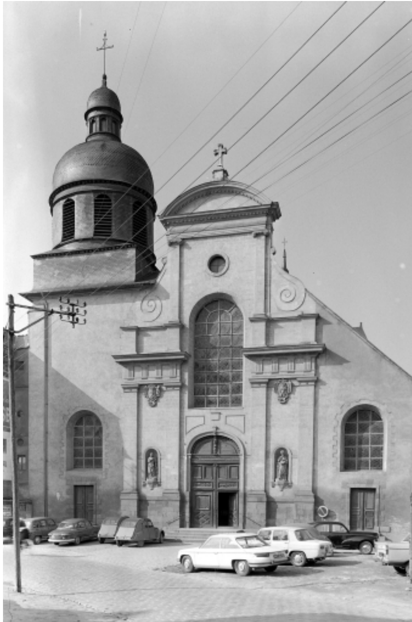
Rennes - Eglise Saint-Etienne - Elévation est, vue générale.
