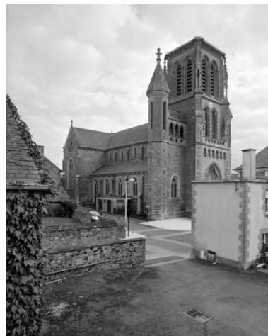
Elévation Nord-Ouest : vue générale Phot. Guy Artur, Phot. Norbert Lambart IVR53_19943501951X
