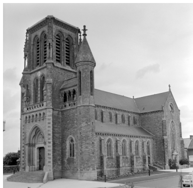
Elévation Sud-Ouest : vue générale Phot. Guy Artur, Phot. Norbert Lambart IVR53_19943501333X
