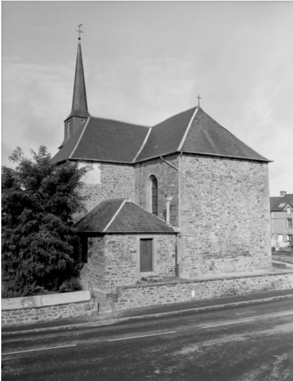
Elévation Est : vue générale
