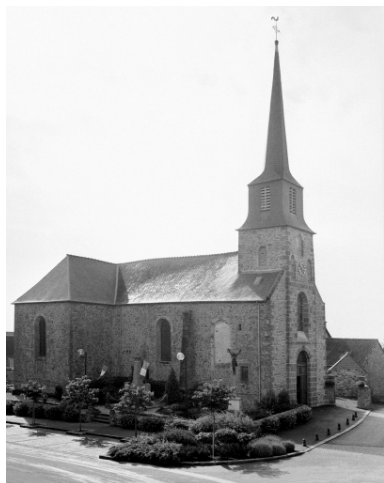
Elévation Nord : vue générale Phot. Guy Artur, Phot. Norbert Lambart IVR53_19943501791X
