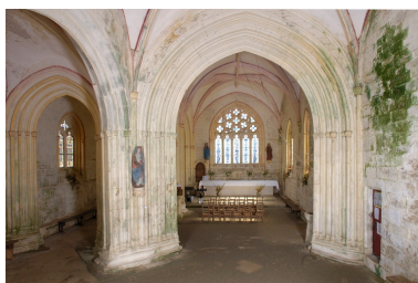
Intérieur, vue de la nef cers le choeur Phot. Alain Dagorn IVR53_20072900218NUCA
