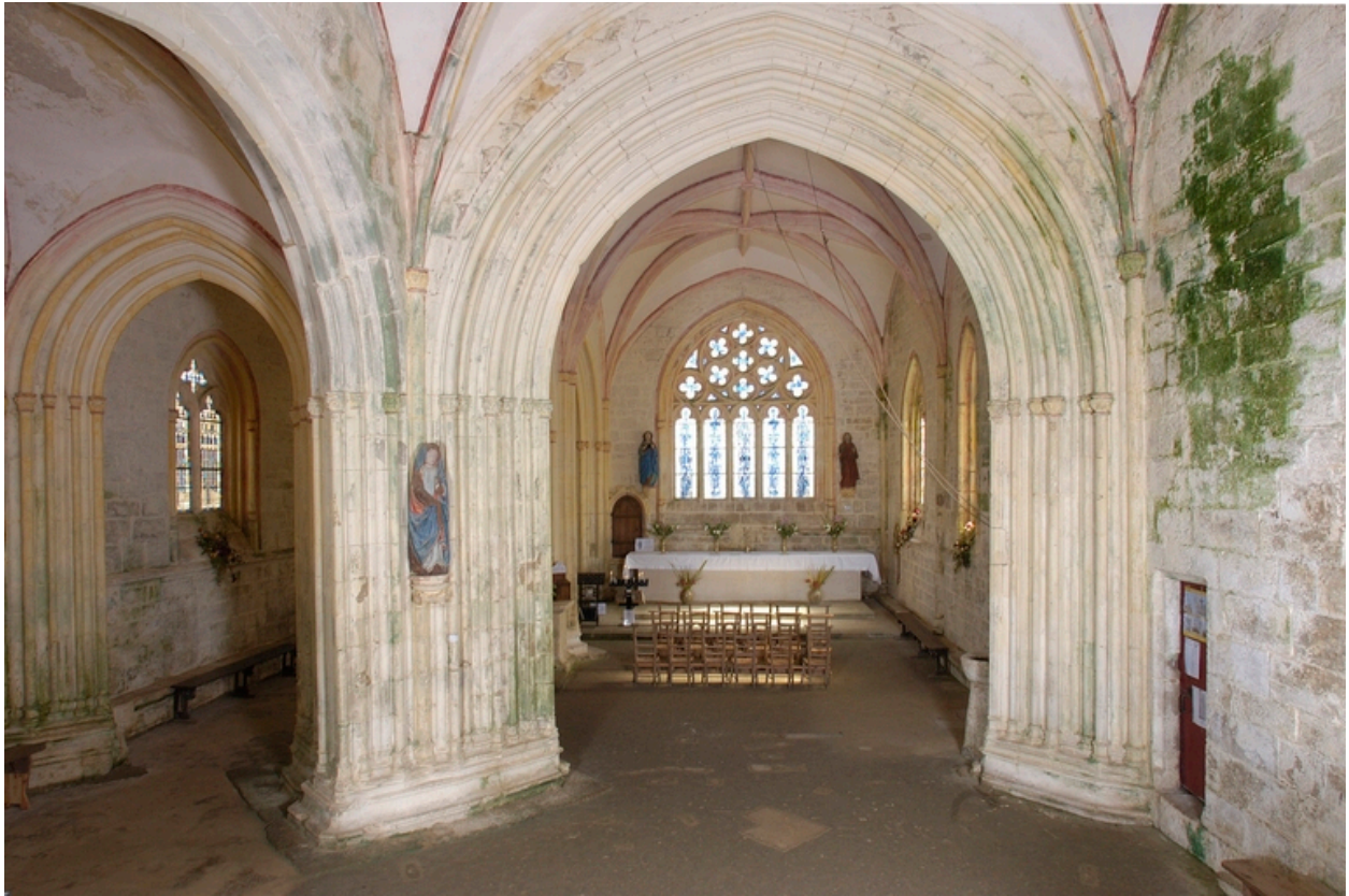
Intérieur, vue de la nef vers le choeur
