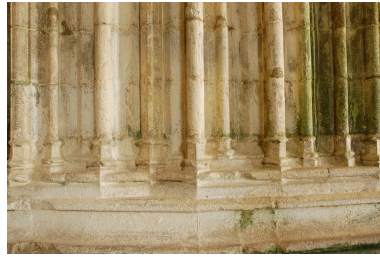
Pile de l'arc d'entrée du choeur, détail des bases Phot. Alain Dagorn IVR53_20072900220NUCA
