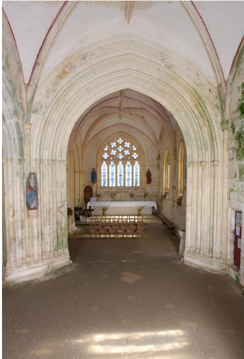
Intérieur, vue de la nef vers le chœur
