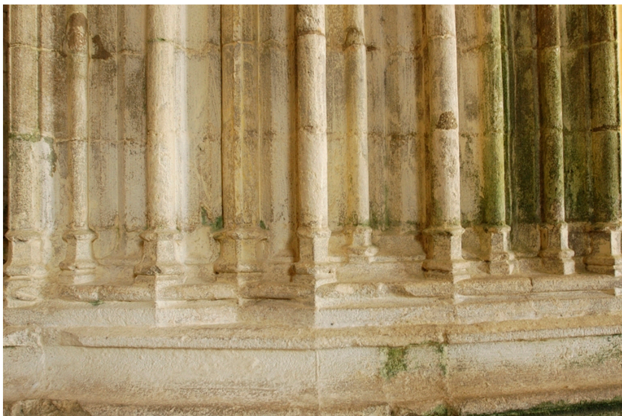
Pile de l'arc d'entrée du choeur, détail des bases
