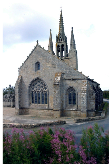
Vue du chevet prise du nord-est Phot. Alain Dagorn IVR53_20072900208NUCA
