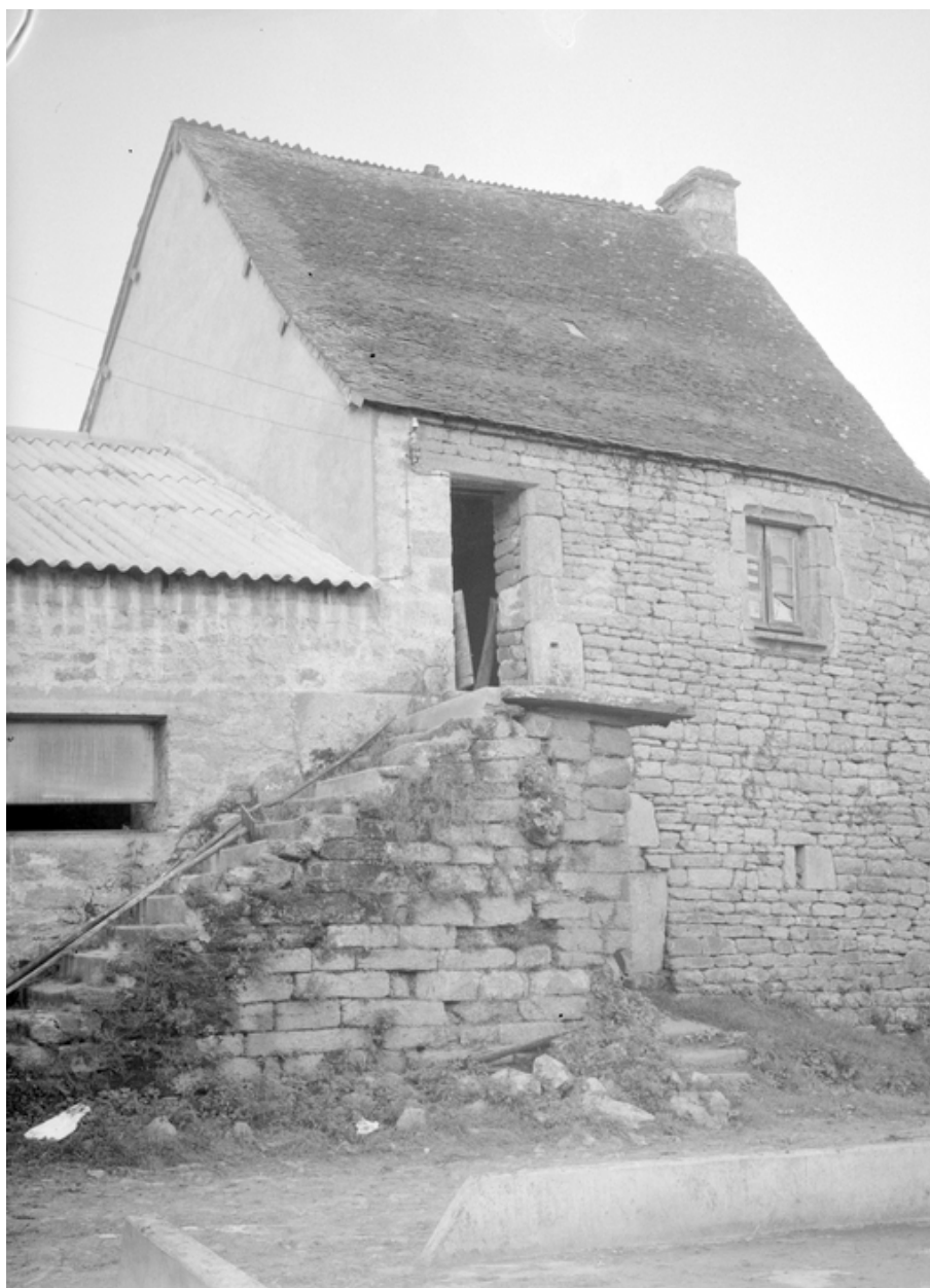
Vue d'ensemble de la façade est
