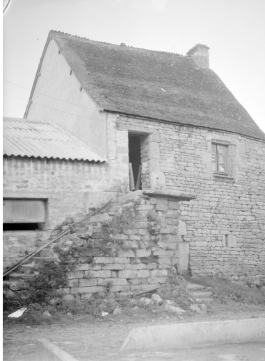
Vue d'ensemble de la façade est Phot. Armand Pâris IVR53_19665600950V
