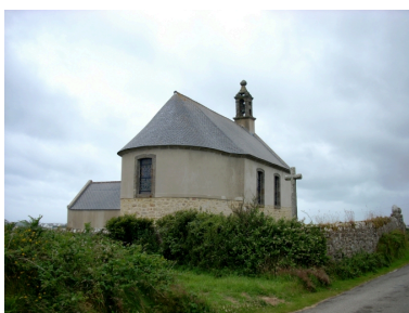
Ouessant, chapelle de Ker Ber : vue générale nord-est Phot. Gwénaél Fauchille IVR53_20082906487NUCA
