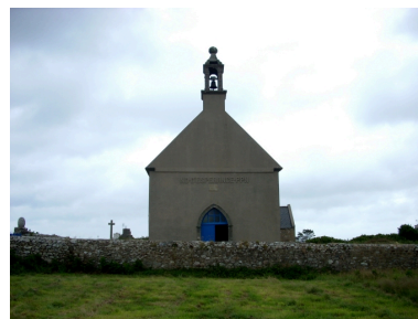
Ouessant, chapelle de Ker Ber : élévation ouest Phot. Gwénaél Fauchille IVR53_20082906485NUCA
