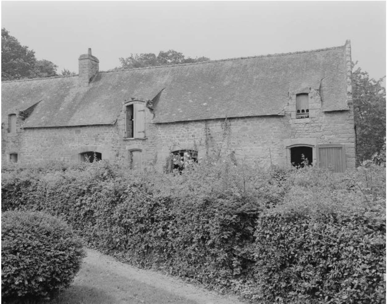
Communs, partie nord, élévation est.
