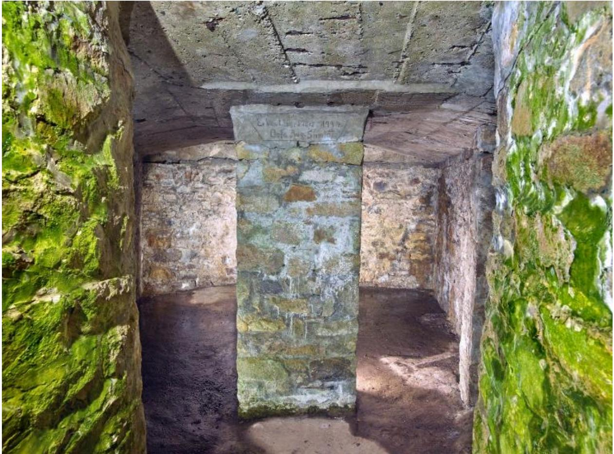
Vue du couloir d'entrée. Enterrée dans le sol, cette construction dispose de murs et de deux piliers en maçonnerie couverts d'une dalle en béton d'environ 30 cm d'épaisseur
