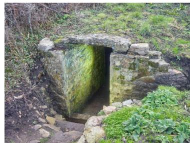
Vue de l'entrée orientée vers le nord. Enterrée dans le sol, cette construction dispose de murs et de deux piliers en maçonnerie couverts d'une dalle en béton
