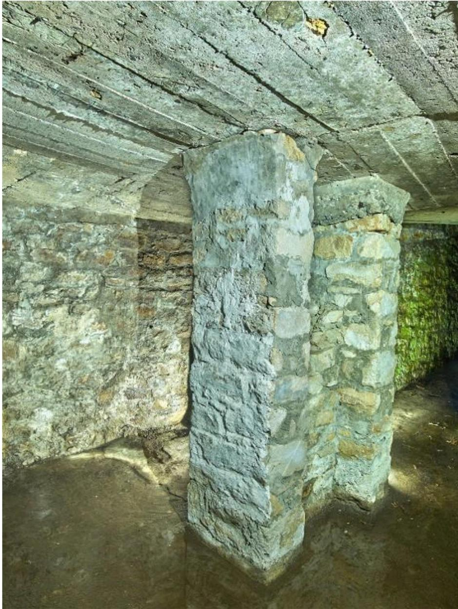
Vue de la salle. Enterrée dans le sol, cette construction dispose de murs et de deux piliers en maçonnerie couverts d'une dalle en béton d'environ 30 cm d'épaisseur
