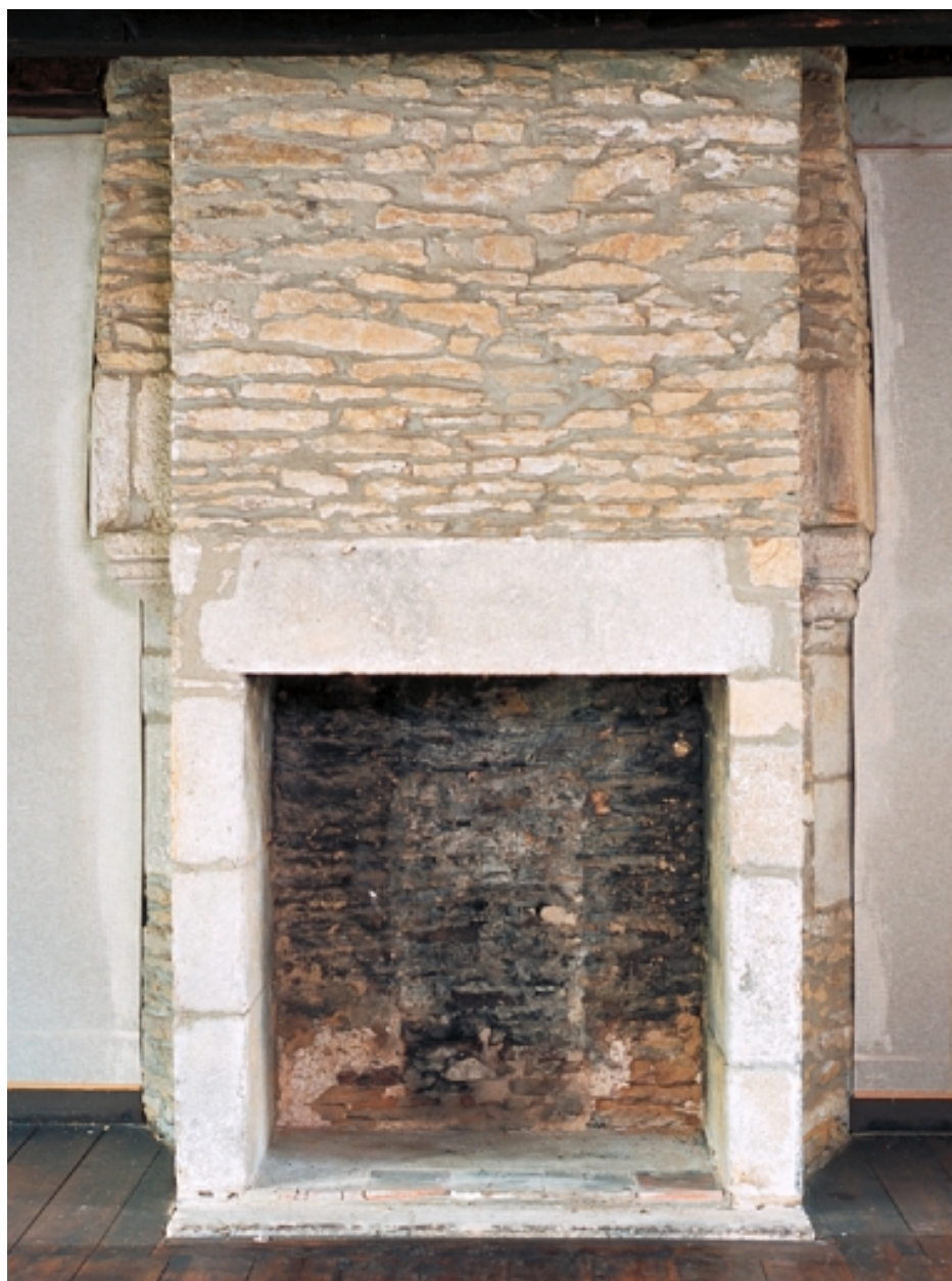
Second étage, mur sud, cheminée
