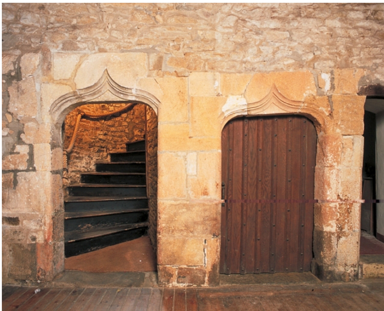
Rez-de-chaussée, portes jumelées donnant accès à l'escalier
