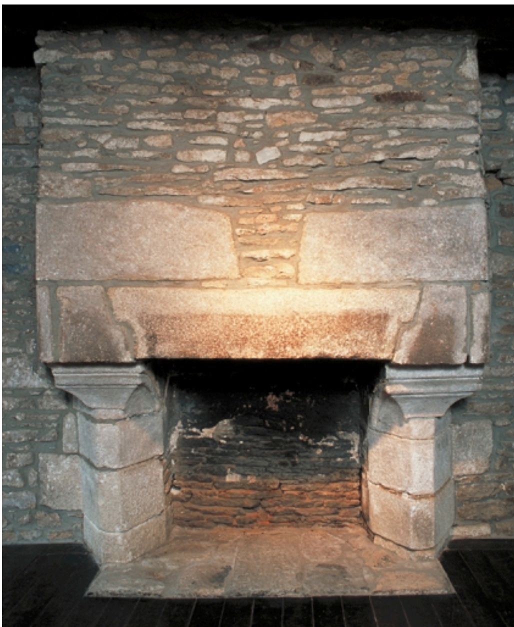
Premier étage, pièce sud, mur nord, cheminée
