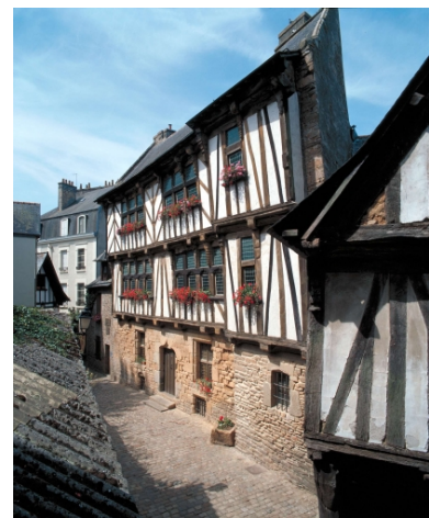
Élévation est, vue générale Phot. Bernard Bègne IVR53_20012900057XA
