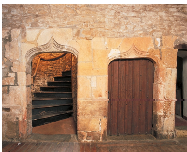
Rez-de-chaussée, portes jumelées donnant accès à l'escalier Phot. Xavier Scheinkmann IVR53_20022900131XA
