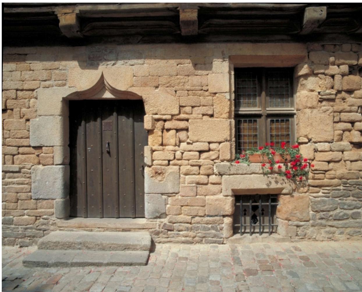
Elévation est, détail des baies du rez-de-chaussée
