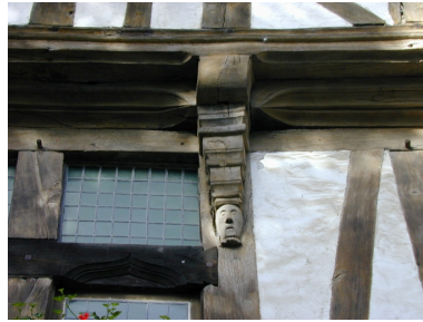
Elévation est, détail d'une console sculptée Phot. Christel Douard IVR53_20032901343NUCA
