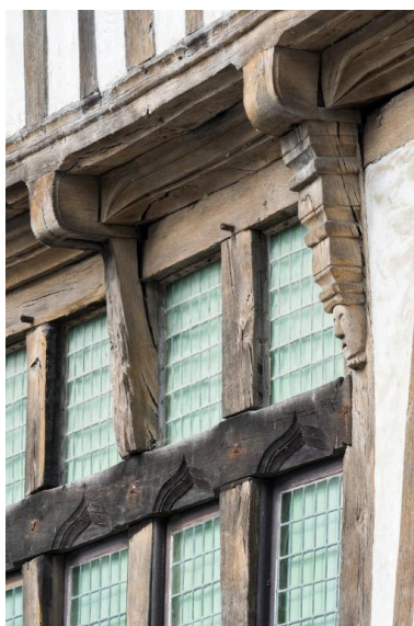
Détail des moulures sur une partie remaniée de la façade en pan de bois. Phot. Charlotte Barraud IVR53_20222900517NUCA
