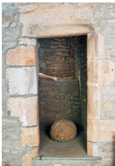
Second étage, salle, mur ouest, accès aux latrines Phot. Xavier Scheinkmann IVR53_20022900137XA
