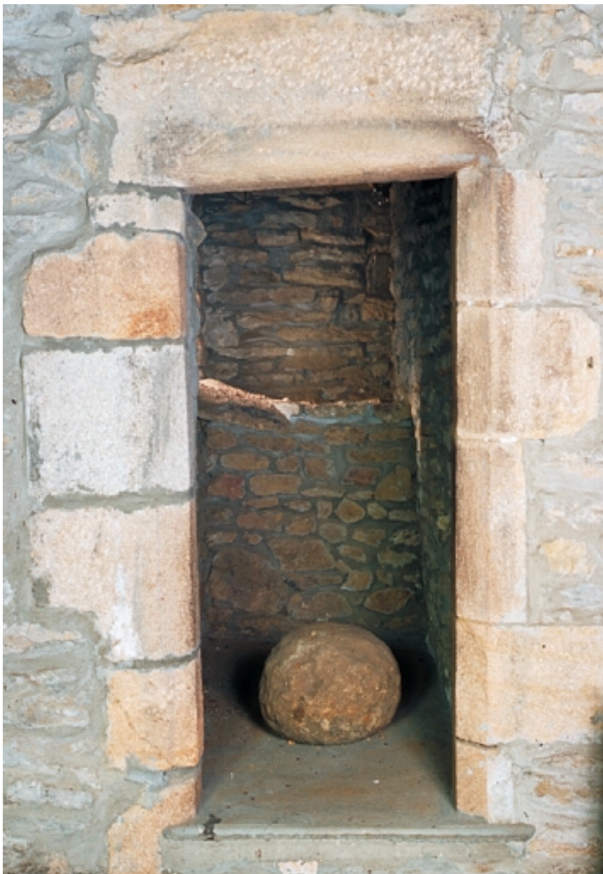
Second étage, salle, mur ouest, accès aux latrines
