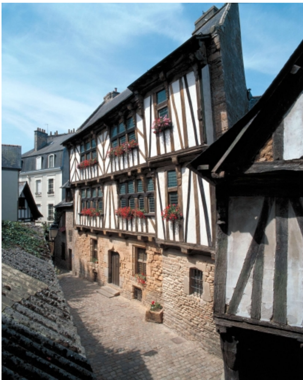
Elévation est, vue générale
