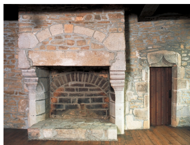
Premier étage, salle, mur nord, cheminée et porte Phot. Xavier Scheinkmann IVR53_20022900132XA
