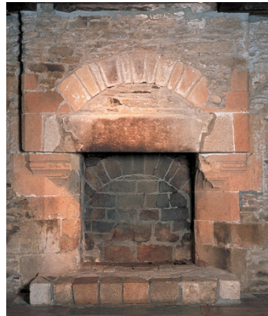
Rez-de-chaussée, cheminée sud Phot. Xavier Scheinkmann IVR53_20022900130XA
