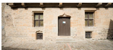
Entièrement maçonné, le rez-de- chaussée est percé de deux soubrebaux, d'une porte ornée d'une accolade et d'une baie de part et d'autre. Phot. Charlotte Barraud IVR53_20222900515NUCA
