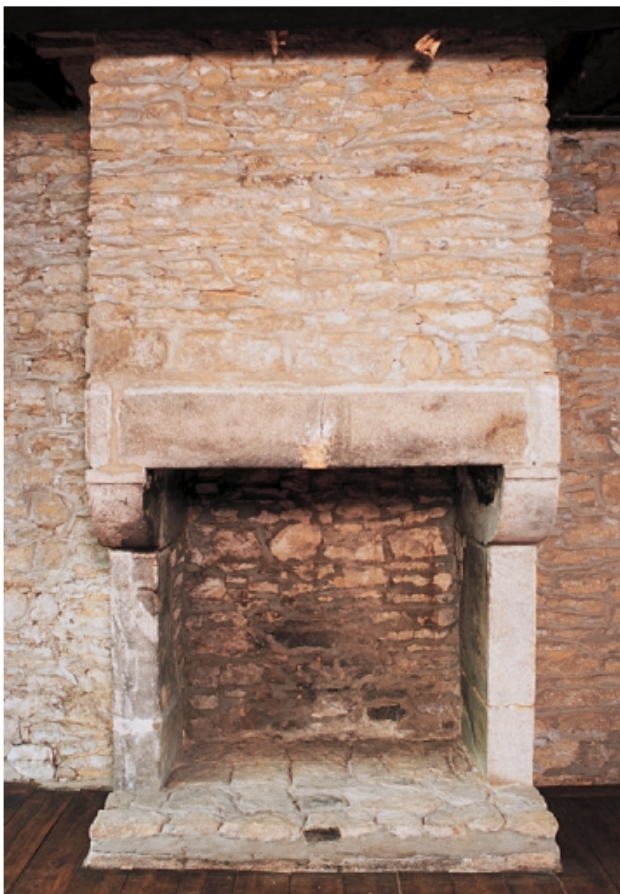
Premier étage, salle, mur sud, cheminée
