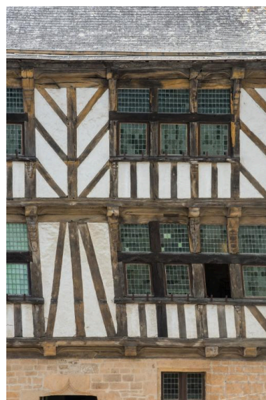
Le contreventement entre les baies se compose d'écharpes au premier étage et de chevrons au second. Phot. Charlotte Barraud IVR53_20222900539NUCA
