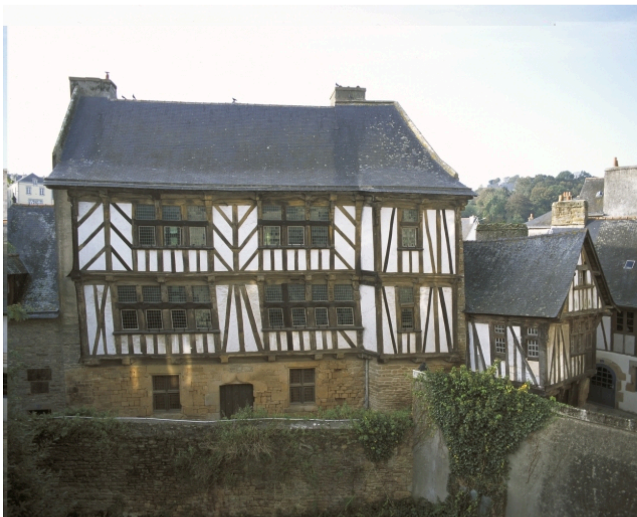
Elévation est, vue générale
