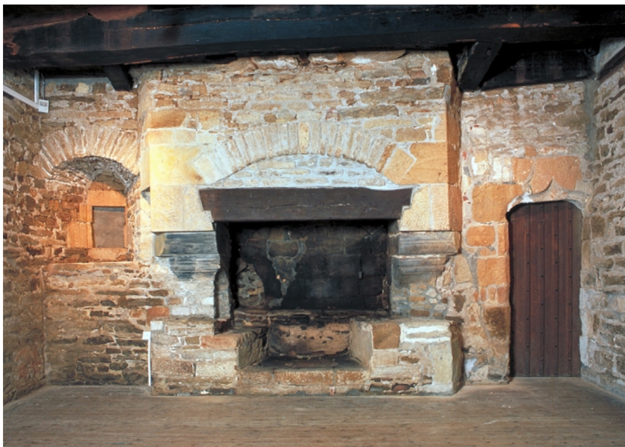
Rez-de-chaussée, mur nord
