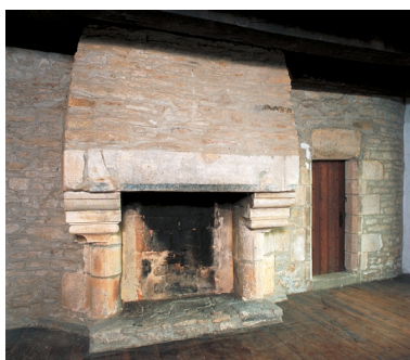
Second étage, mur nord, cheminée et porte Phot. Xavier Scheinkmann IVR53_20022900135XA
