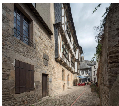
A deux niveaux en encorbellement, la façade présente une avancée sur la rue au nord. Phot. Charlotte Barraud IVR53_20222900514NUCA
