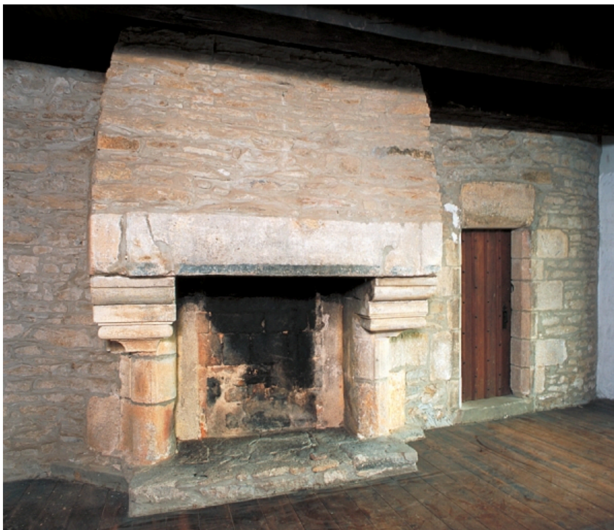
Second étage, mur nord, cheminée et porte
