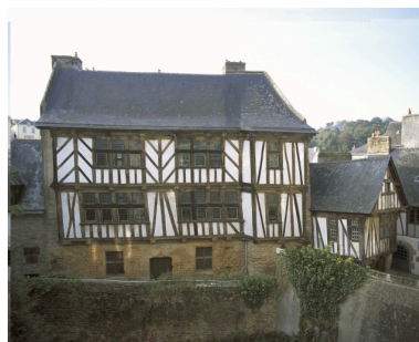
Élévation est, vue générale Phot. Bernard Bègne IVR53_20012900372XA
