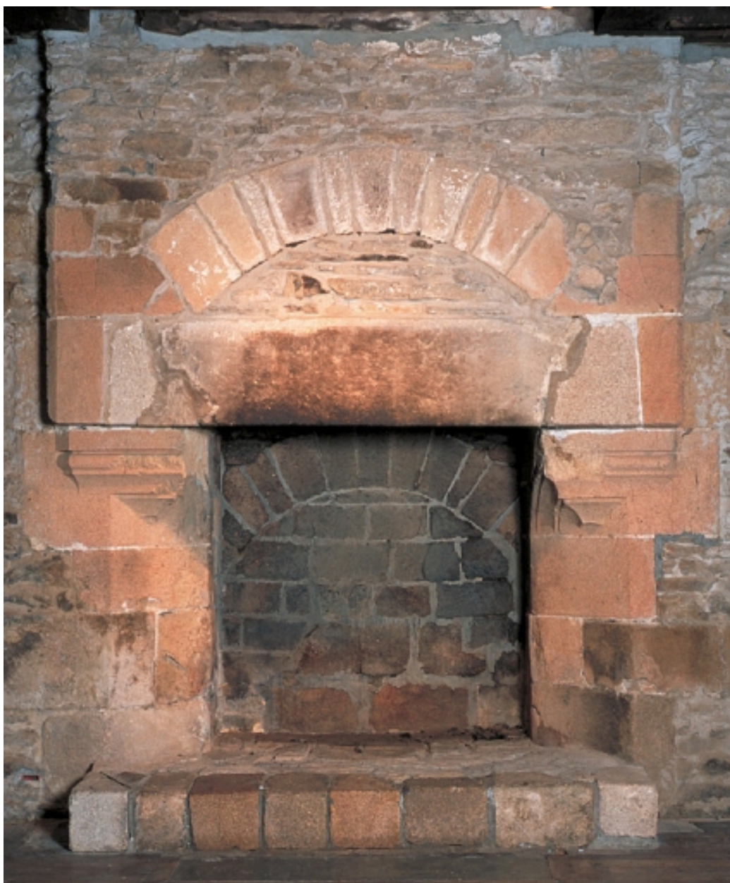
Rez-de-chaussée, cheminée sud
