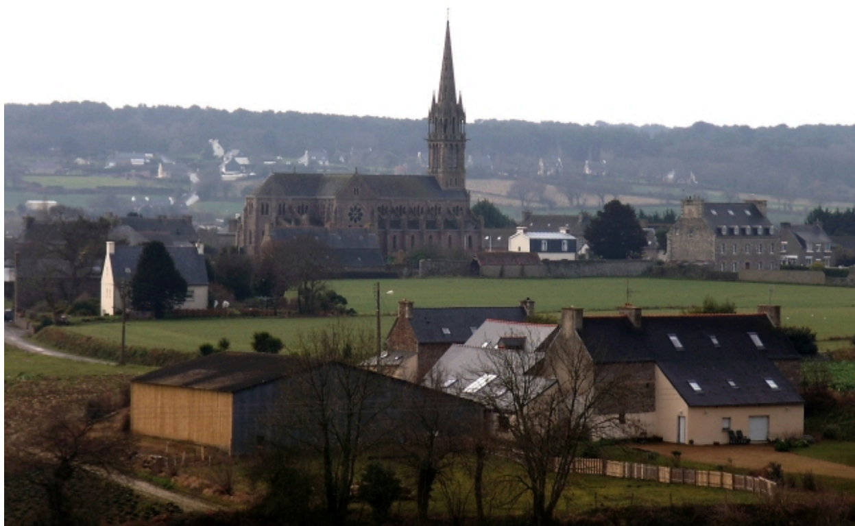
Paimpol, vue générale de l'écart de Plounez prise depuis le nord-est
