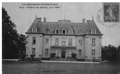
Vue de la façade principale Phot. Auteur inconnu IVR53_19883500221XB
