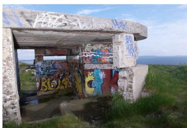
Vue du poste de commandement ouest (état en 2009). Il a été doté de murs périphériques et couvert d'une dalle en béton armé
