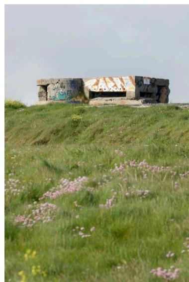
Vue du poste de commandement ouest (état en 2009). Il a été doté de murs périphériques et couvert d'une dalle en béton armé
