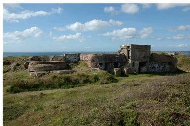
Vue de l'extrémité ouest : poste de commandement (état en 2007). Il a été doté de murs périphériques et couvert d'une dalle en béton armé
