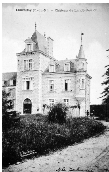
Vue du corps de bâtiment fin 19e siècle Phot. Elise Lauranceau IVR53_20042209001NUCB
