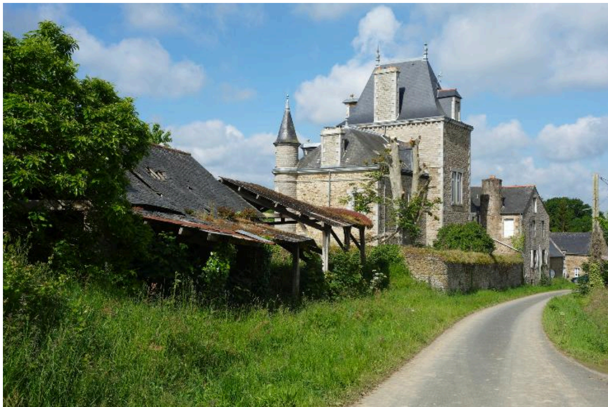
Vue générale des façades arrières donnant sur le chemin communal
