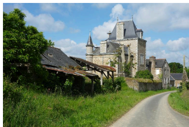
Vue générale des façades arrières donnant sur le chemin communal Phot. Norbert Lambart IVR53_20142201338NUCA
