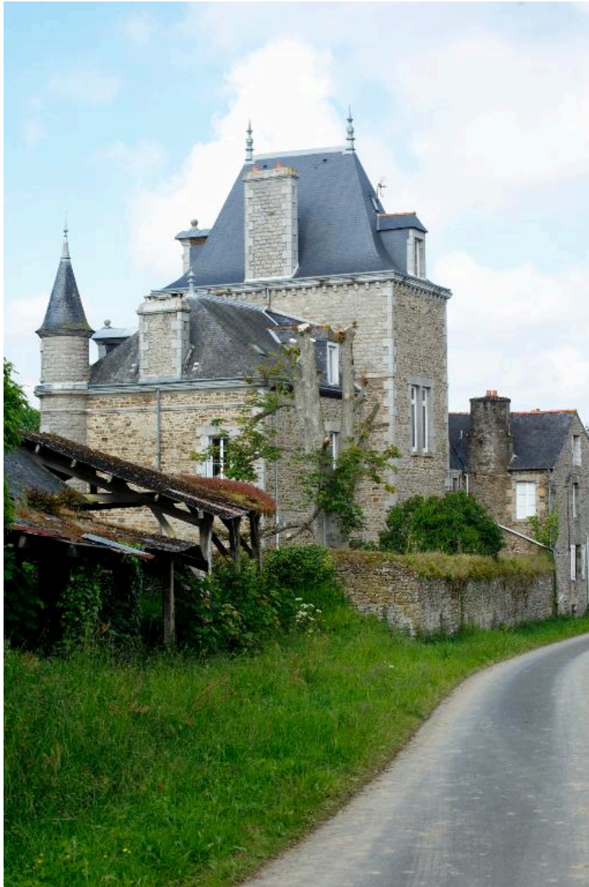
Vue générale des façades arrière prises du chemin communal
