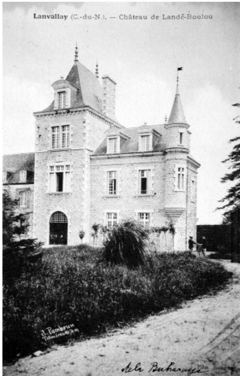
Vue du corps de bâtiment fin 19e siècle
