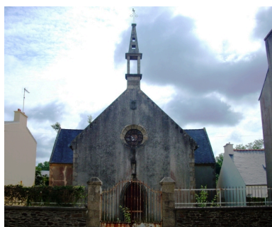
Chapelle Sainte-Anne de Kerinou : élévation ouest Phot. Gwénaél Fauchille IVR53_20082906048NUCA
