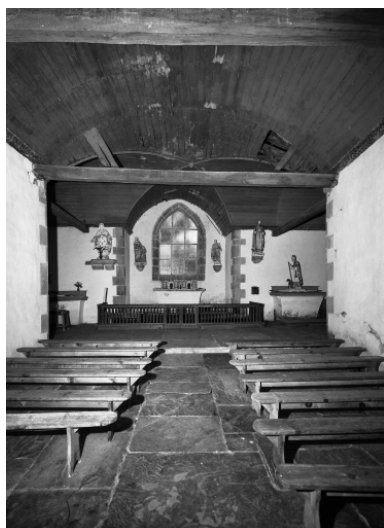
Saint-Thois, chapelle Saint-Laurent : vue générale intérieure vers l'est, état en 1966 Phot. François Dagorn IVR53_19662900143V
