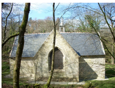
Saint-Thois, chapelle Saint-Laurent : élévation est Phot. Gwénaél Fauchille IVR53_20082905616NUCA
