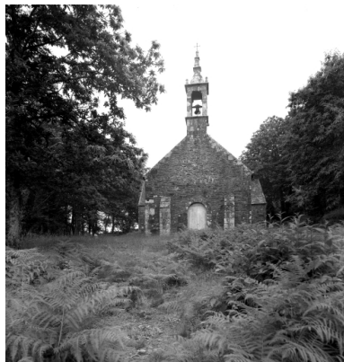
Saint-Thois, chapelle Saint-Laurent : vue générale ouest, état en 1966 Phot. François Dagorn IVR53_19662900141V
