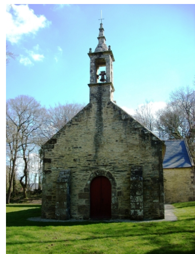
Saint-Thois, chapelle Saint-Laurent : élévation ouest Phot. Gwénaél Fauchille IVR53_20082905614NUCA
