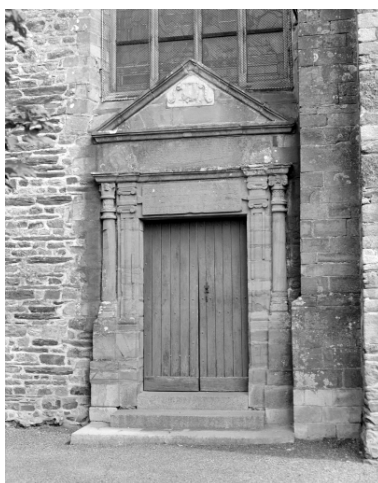
Elévation Sud, porte : vue générale Phot. Guy Artur, Phot. Norbert Lambart IVR53_19943501341X
