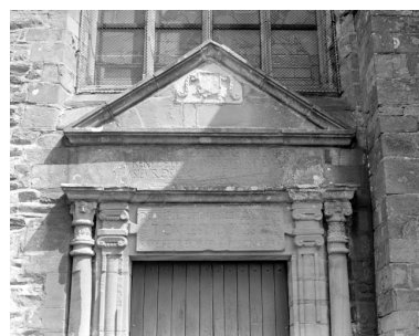
Elévation Sud, porte : détail du tympan Phot. Guy Artur, Phot. Norbert Lambart IVR53_19943501347X
