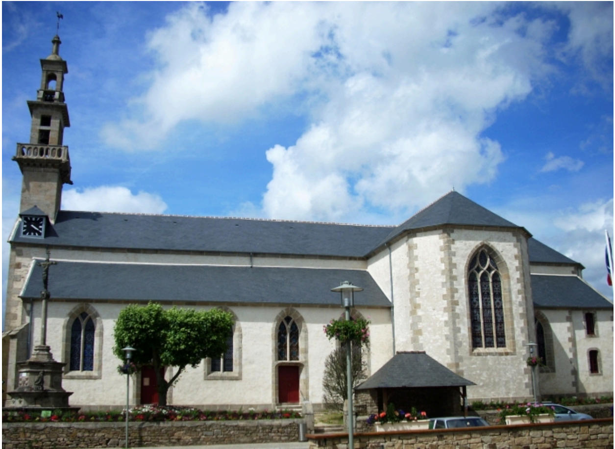
Plouvien, église paroissiale : vue générale sud
