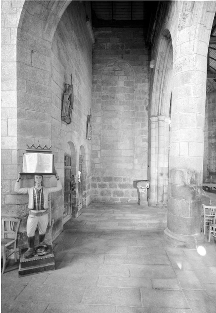
Ouverture murée sur le mur ouest du bas-côté sud
