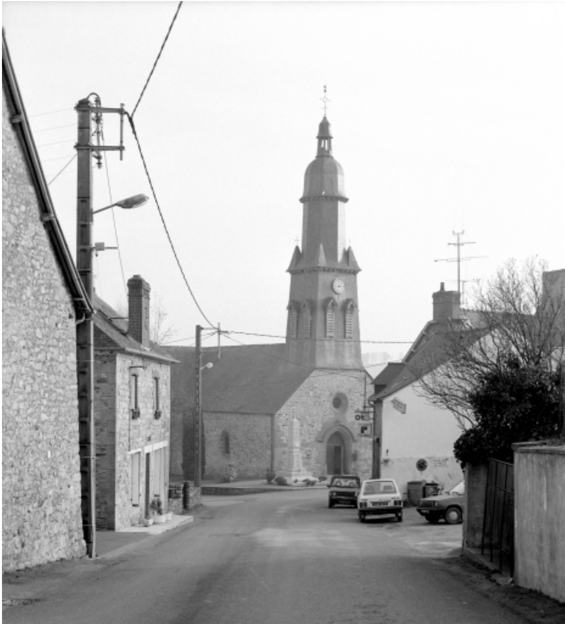
Elévation Nord-Ouest : vue générale
