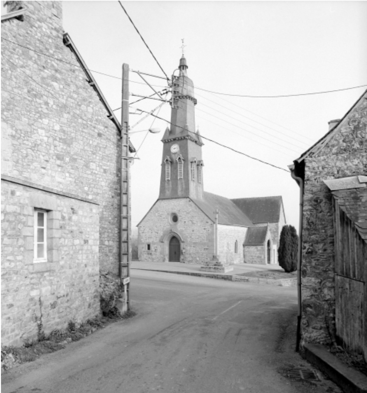
Elévation Sud-Ouest : vue générale
