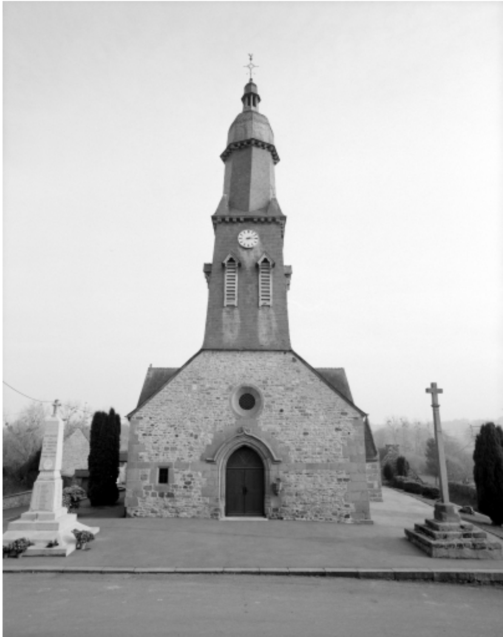
Elévation Ouest : vue générale
