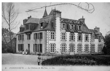
Vue générale Phot. Elise Lauranceau IVR53_20042905549NUCB
