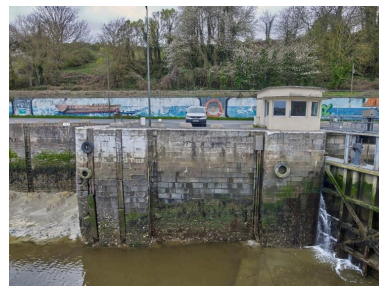
Tête aval de l'écluse : quai d'attente et de quidage, musoir, rainure à batardeau, maçonnerie de pierre de taille, poste de commande, porte busquée et faux-busc Phot. Bernard Bègne IVR53_20262200285NUCA
