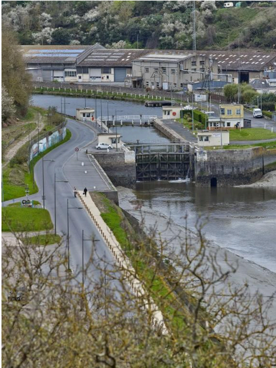
Vue de situation du site d'écluse à marée basse
