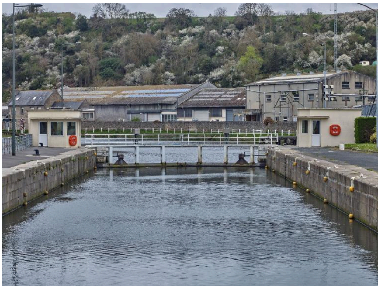
Les portes amont de l'écluse
