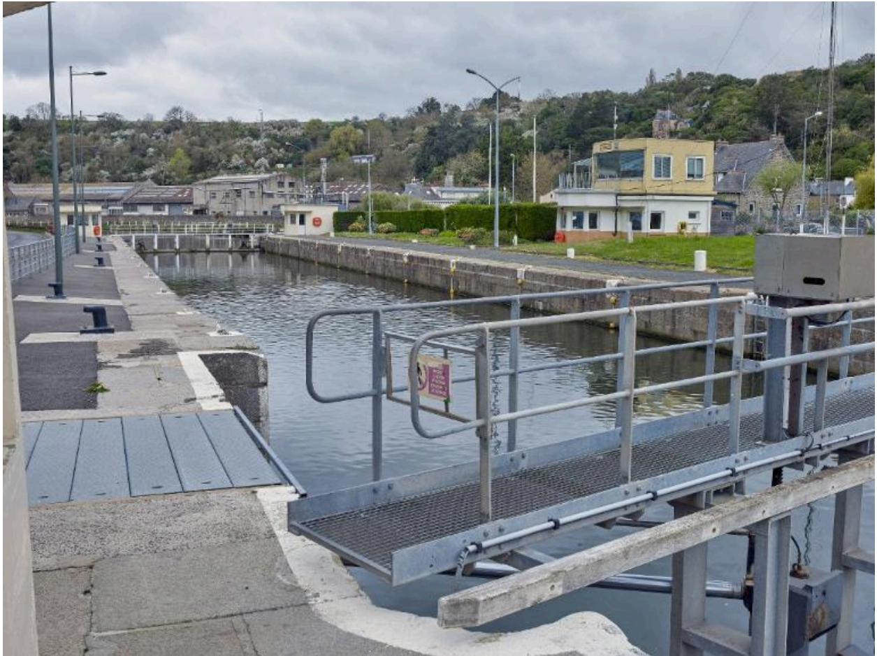
Passerelle et sas de l'écluse
