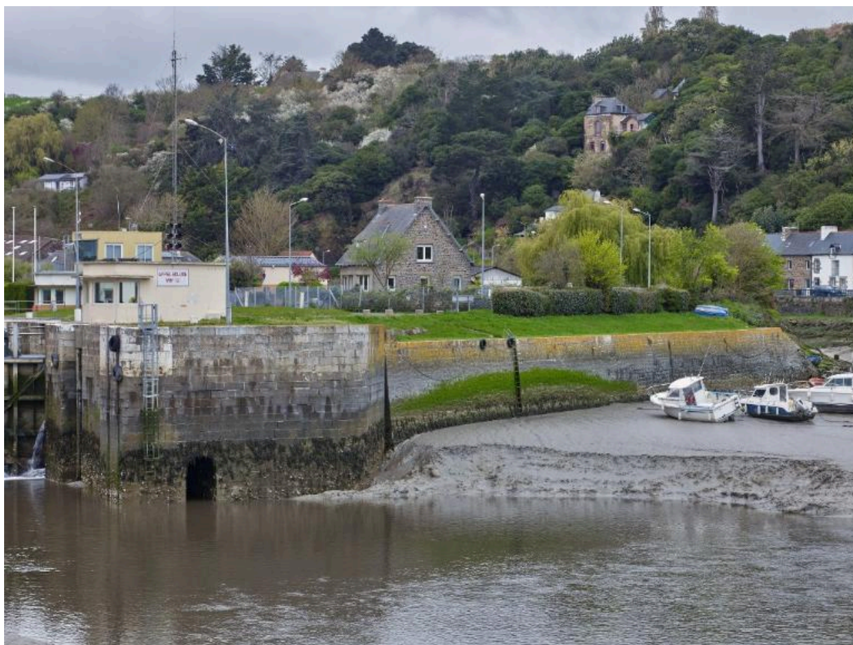
Ecluse et quai d'attente de l'île sèche
