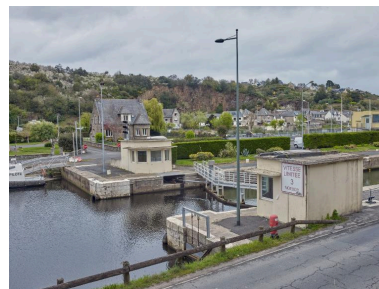
Vue des deux postes d'écluse en amont Phot. Bernard Bègne IVR53_20262200277NUCA
