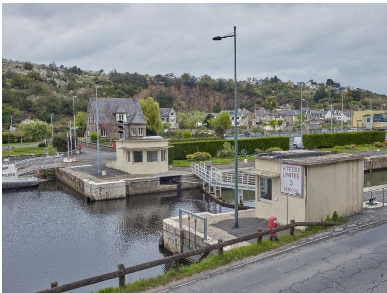
Vue des deux postes d'écluse en amont
