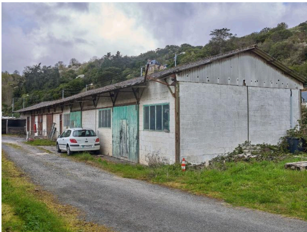
Anciens ateliers associé aux anciens logements des éclusiers et maître du port
