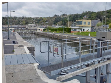
Passerelle et sas de l'écluse Phot. Bernard Bègne IVR53_20262200287NUCA
