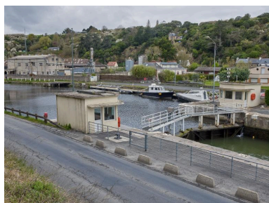
Les postes de commande amont de l'écluse, le quai des pilotines et l'île sèche et l'ancienne usine de bitume
