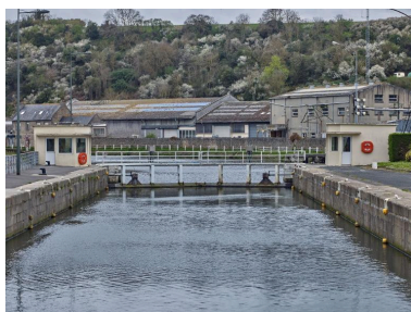
Les portes amont de l'écluse Phot. Bernard Bègne IVR53_20262200288NUCA
