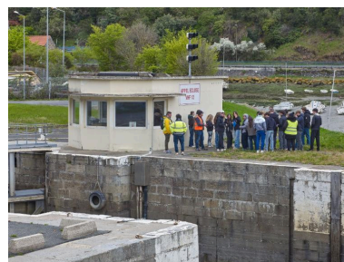
Visite du site des écluses par des lycéens de Troyes Phot. Bernard Bègne
