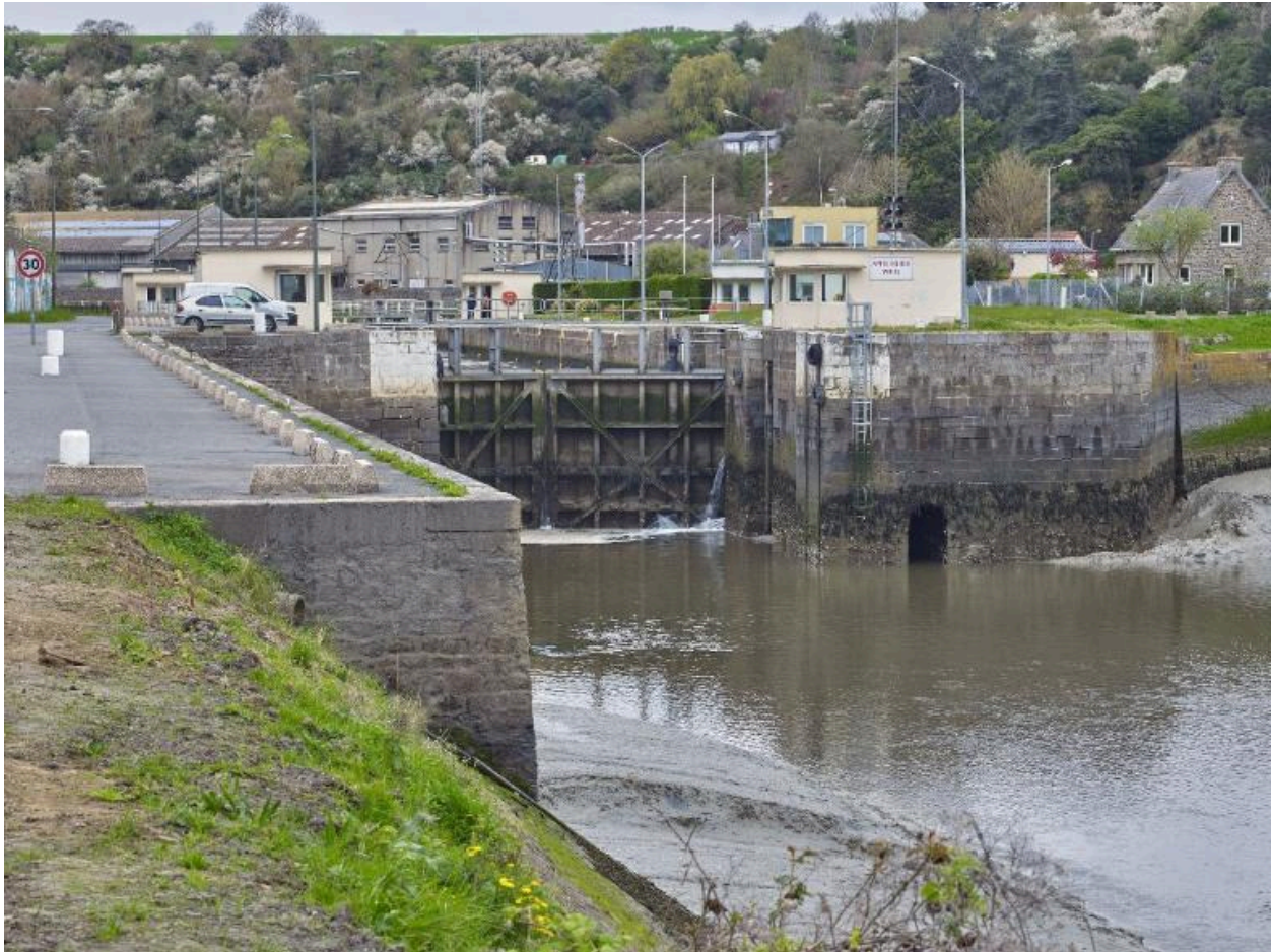
Vue de situation de l'écluse en aval depuis les perrés et quai d'attente
