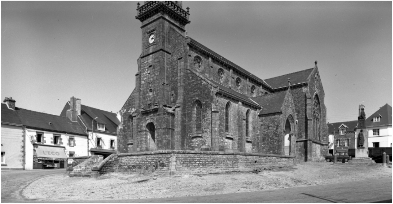
Coray, église paroissiale Saint-Pierre et Saint-Paul : vue générale sud-ouest, état en 1966
