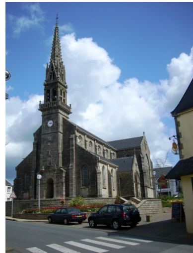
Coray, église paroissiale Saint-Pierre et Saint-Paul : vue générale sud-ouest Phot. Gwénaél Fauchille IVR53_20082905532NUCA
