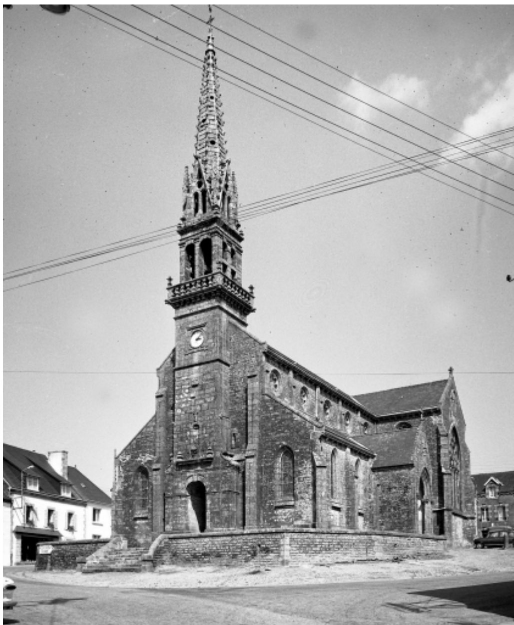
Coray, église paroissiale Saint-Pierre et Saint-Paul : vue générale sud-ouest, état en 1966
