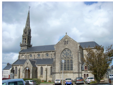
Coray, église paroissiale Saint-Pierre et Saint-Paul : vue générale sud Phot. Gwénaél Fauchille IVR53_20082905534NUCA
