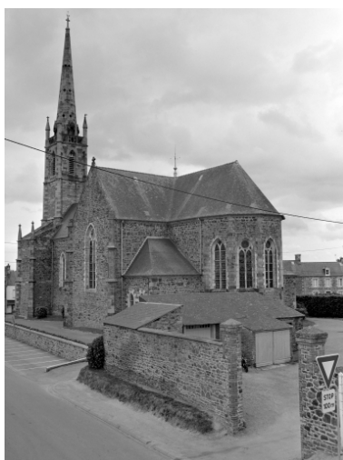
Elévation sud-ouest : vue générale
