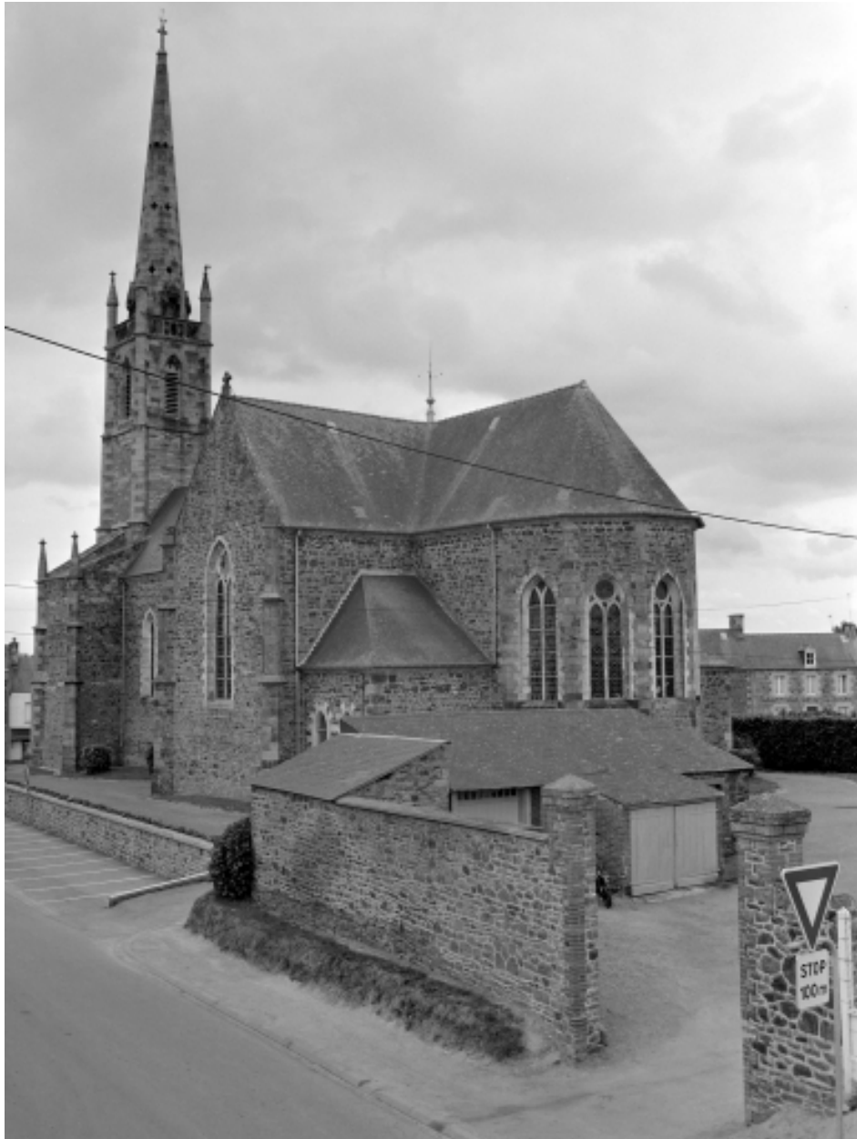
Elévation sud-ouest : vue générale
