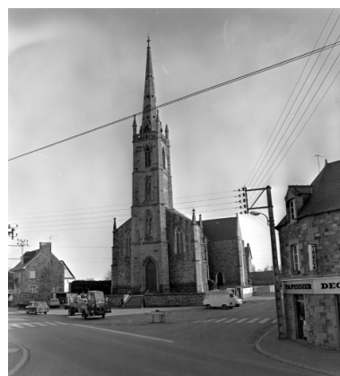
Elévation ouest : vue générale Phot. Guy Artur IVR53_19773500389X
