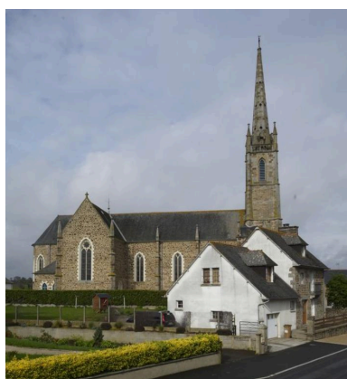
Vue générale Phot. Norbert Lambart IVR53_20123500681NUCA
