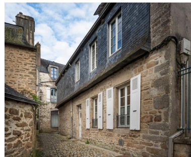
Le premier étage de cette maison est en pan de bois, masqué par des ardoises. Phot. Léna Leroy IVR53_20252900526NUCA
