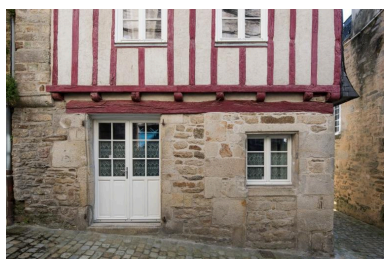
Des reprises au niveau des ouvertures se lisent dans ce rez-de-chaussée maçonné. Phot. Charlotte Barraud IVR53_20252900696NUCA
