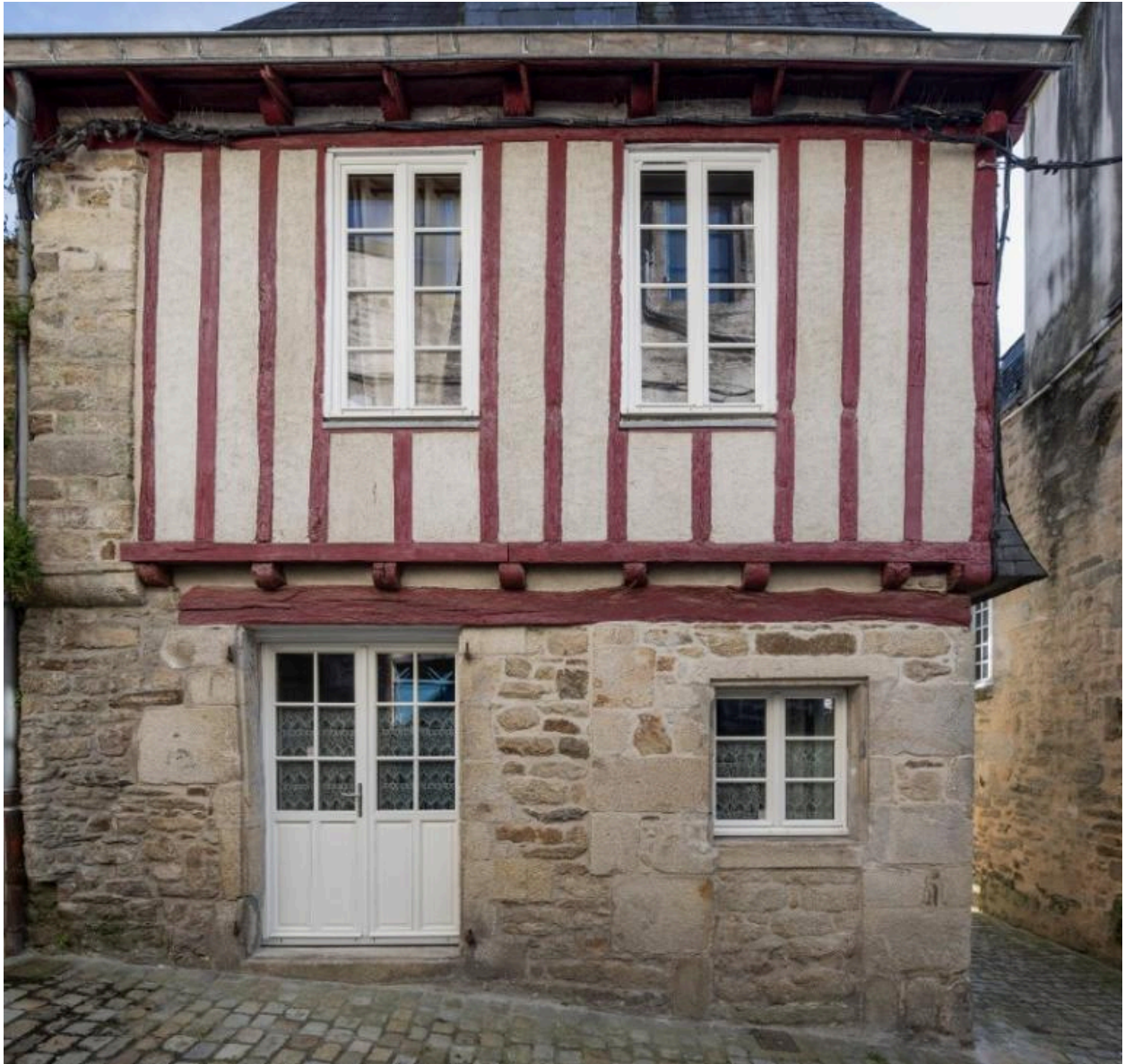
Étage en encorbellement sur solives et contreventement en grille.
