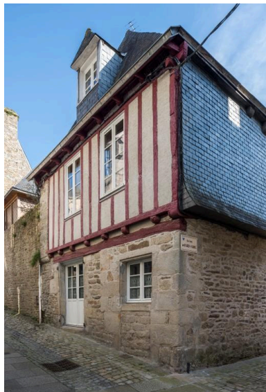
Une partie du pan de bois de l'étage est cachée par un essentage d'ardoises. Phot. Charlotte Barraud IVR53_20252900694NUCA
