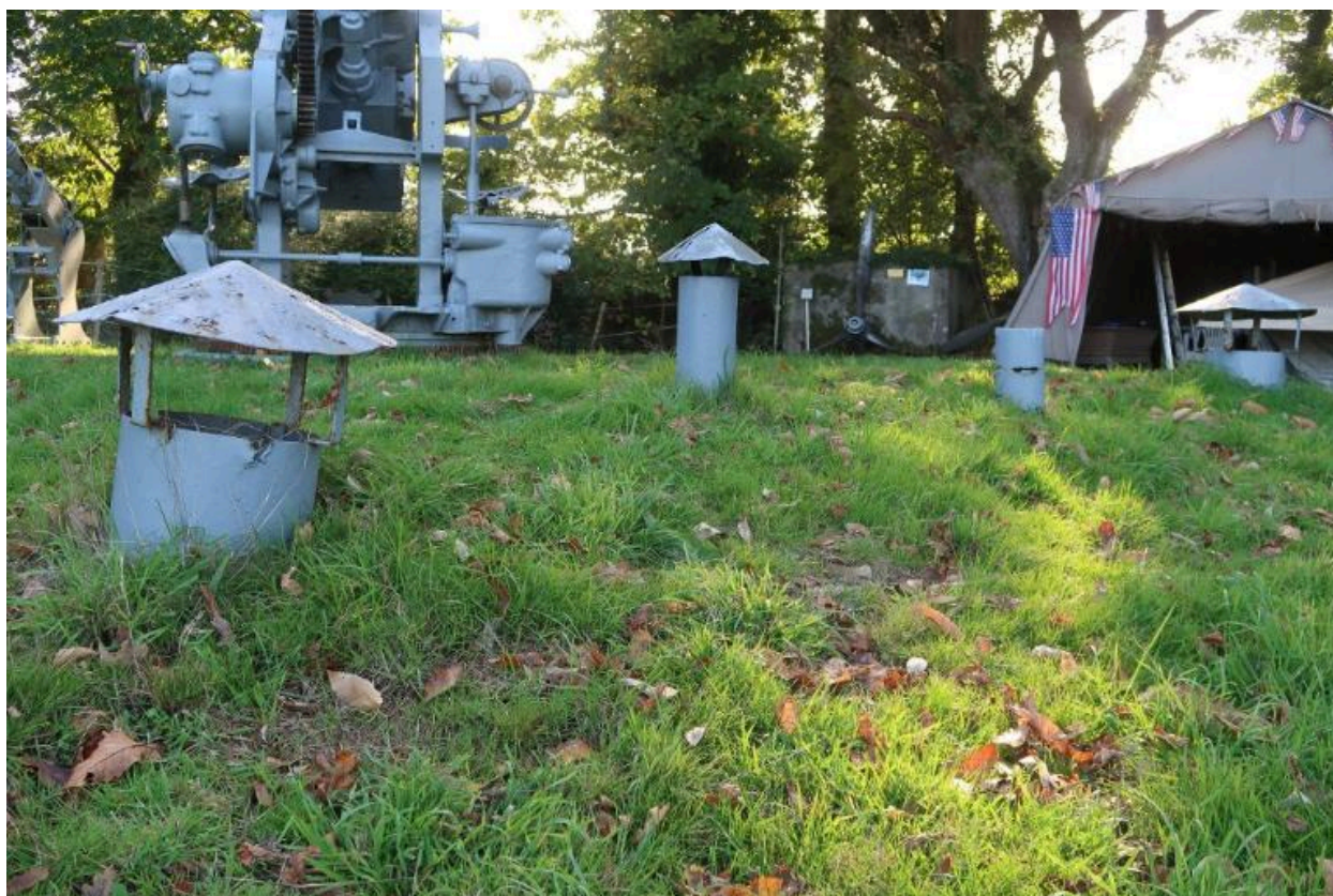
Vue de la dalle de couverture camouflée par de la terre du bunker-abri de type FI245 pour groupe électrogène : ensemble de cheminée et ventilation de bunker
