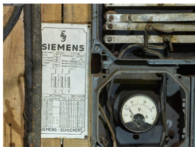
Vue intérieure : salle des machines pour deux groupes électrogènes, détail du tableau électrique de la batterie antiaérienne Rossitten. A gauche, plaque constructeur Siemens-Schuckert Phot. Bernard Bègne IVR53_20255600882NUCA
