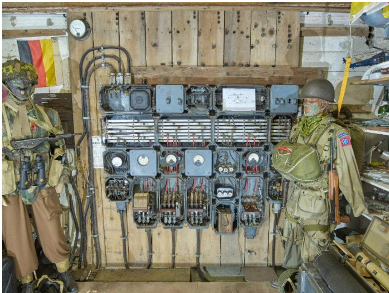
Vue intérieure : salle des machines pour deux groupes électrogènes, tableau électrique de la batterie antiaérienne Rossitten. Ce bunker-musée a pour thématique la Seconde Guerre mondiale
