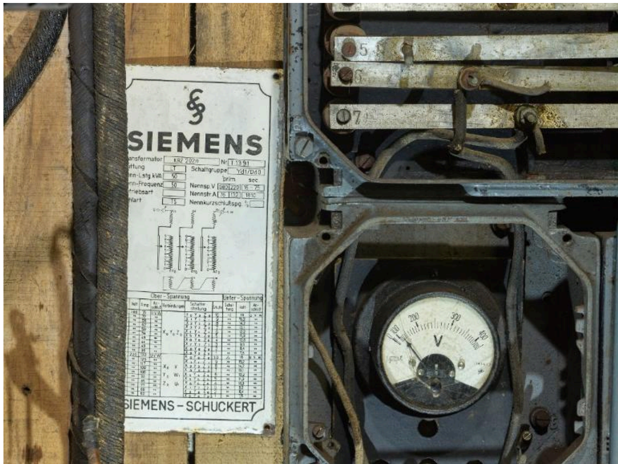
Vue intérieure : salle des machines pour deux groupes électrogènes, détail du tableau électrique de la batterie antiaérienne Rossitten. A gauche, plaque constructeur Siemens-Schuckert
