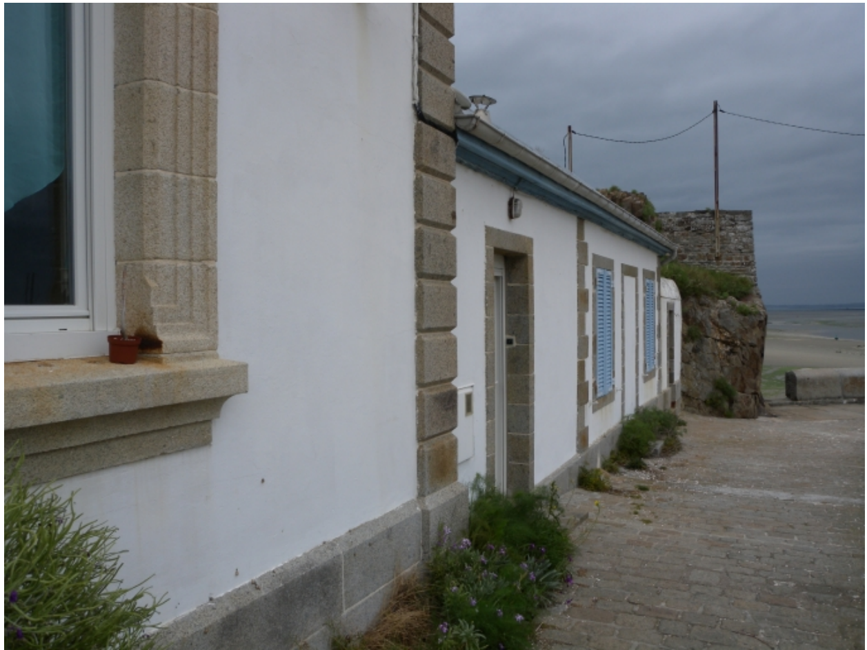
Vue des anciens bâtiments des Phares et Balises, dans le prolongement de la digue du phare
