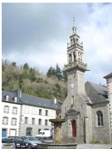
Port-Launay, église paroissiale Saint-Nicolas : vue générale sud-ouest Phot. Gwénaél Fauchille IVR53_20082905602NUCA
