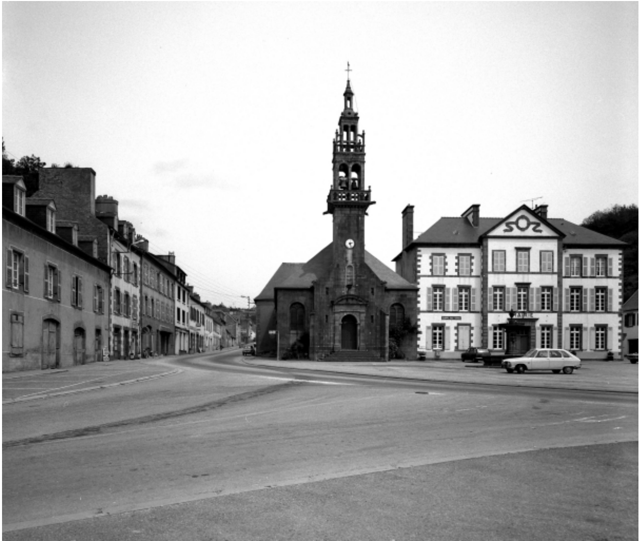
Port-Launay, église paroissiale Saint-Nicolas : vue de situation ouest, état en 1972
