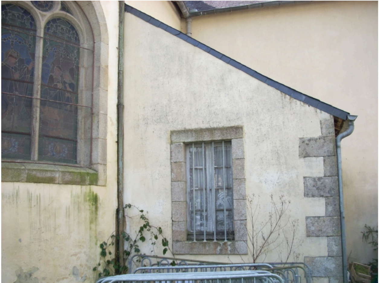
Port-Launay, église paroissiale Saint-Nicolas : sacristie nord
