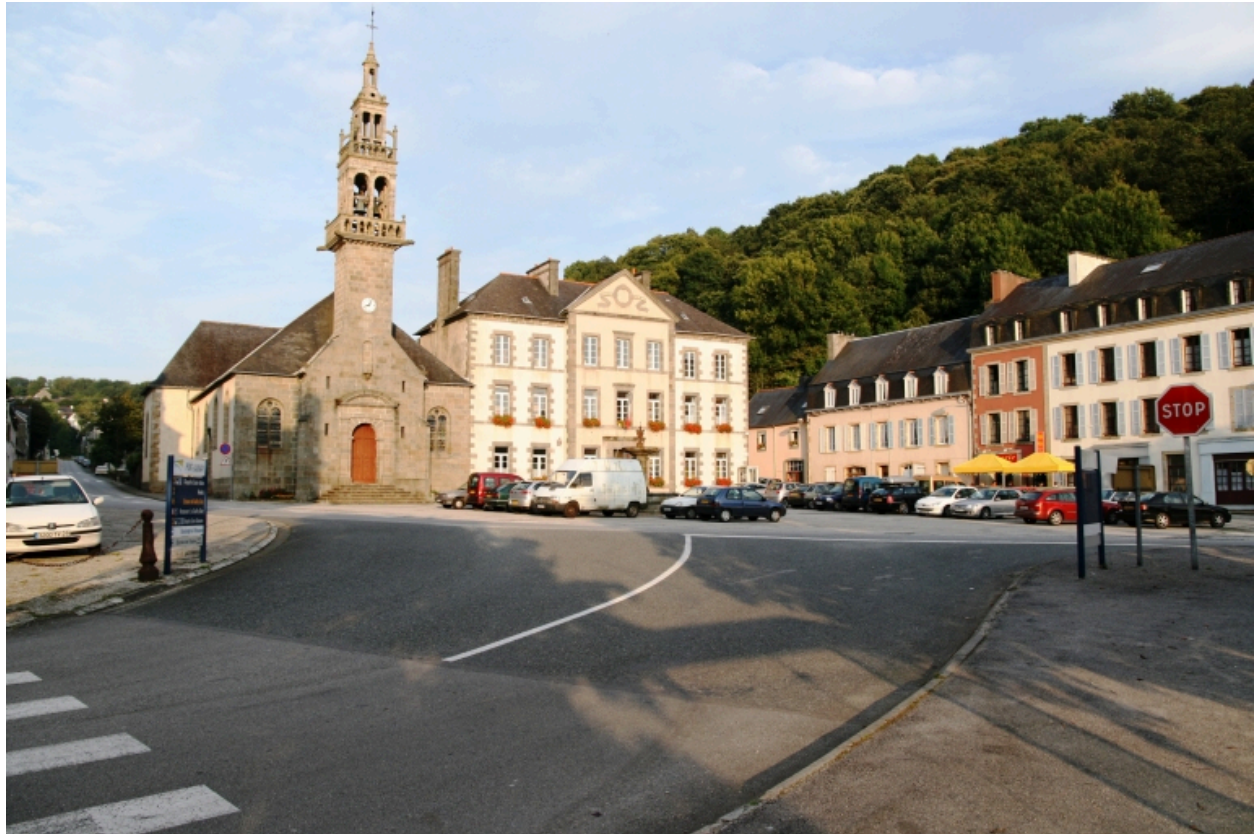
Port-Launay, église paroissiale Saint-Nicolas : vue de situation depuis le nord-ouest
