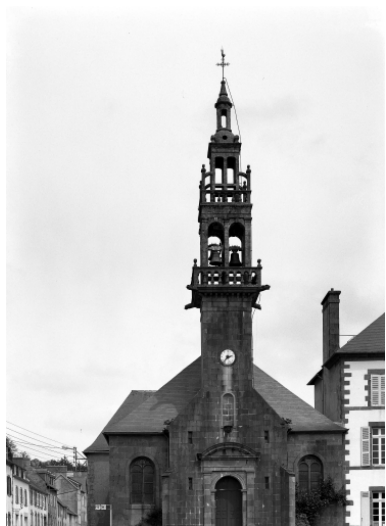
Port-Launay, église paroissiale Saint-Nicolas : façade ouest, le clocher, état en 1972 Phot. François Dagorn IVR53_19722900365V
