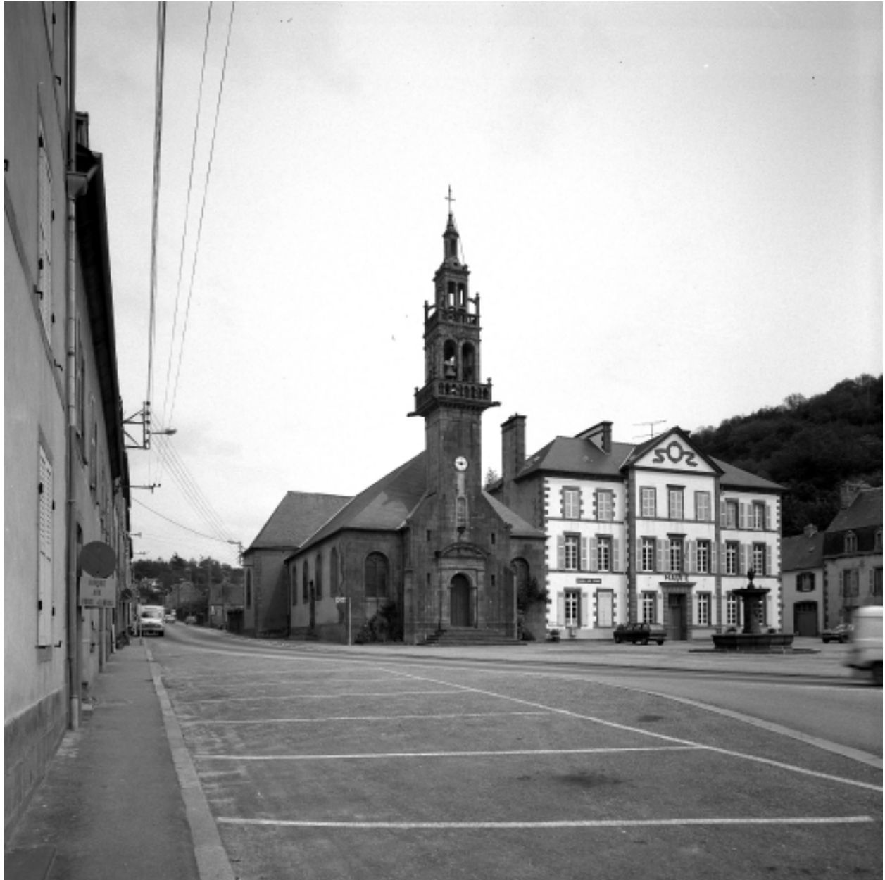
Port-Launay, église paroissiale Saint-Nicolas : vue générale nord-ouest, état en 1972
