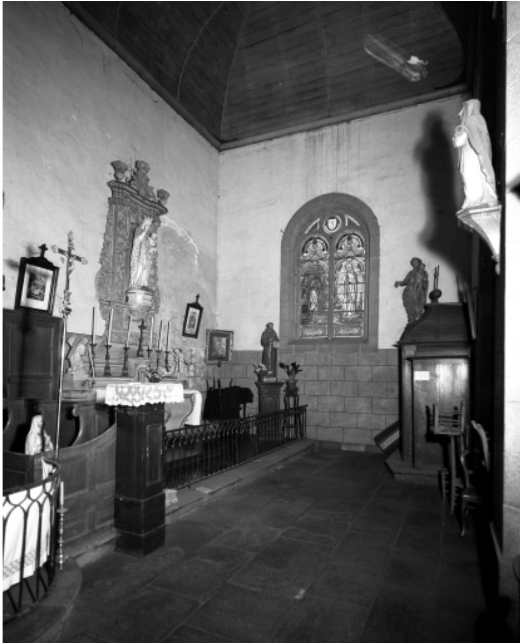
Port-Launay, église paroissiale Saint-Nicolas : bras sud du transept, état en 1972
