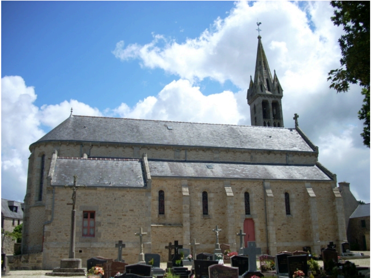
Tréouergat, église paroissiale : vue générale nord
