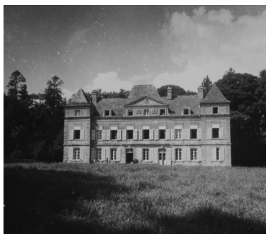
Vue générale de la façade dans les années 1960 Phot. Elise Lauranceau, Autr. Jos Le Doaré IVR53_20052904386NUCB
