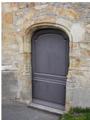
Porte de la façade sud-ouest Phot. Sabrina Dalibard IVR53_20043511653NUCA
