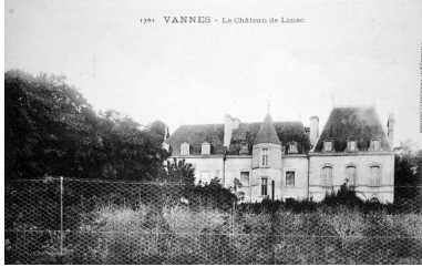
Vue générale Phot. Elise Lauranceau IVR53_20045606246NUCB
