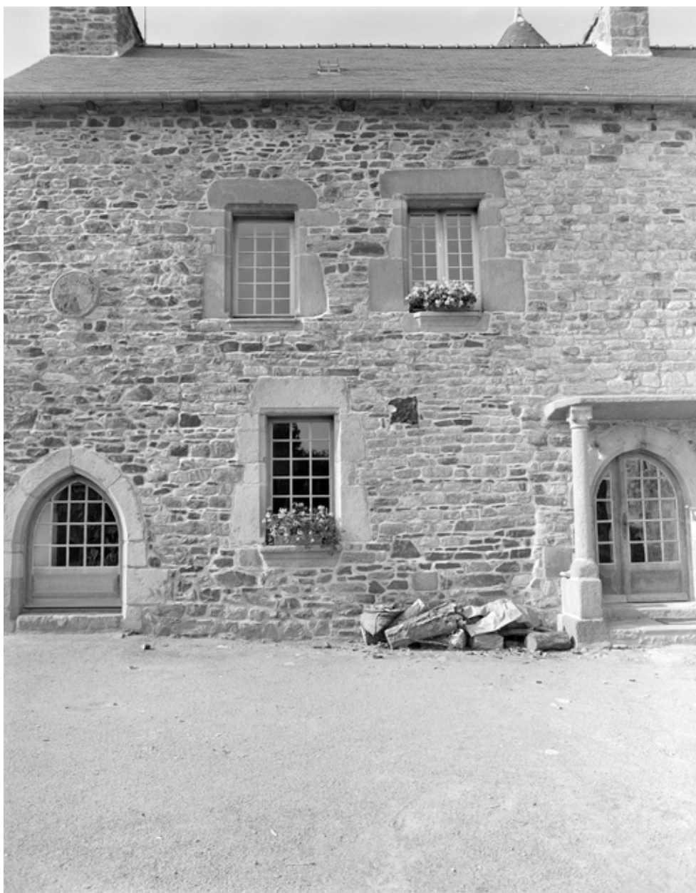
Fenêtre sud (ouest de la porte)
